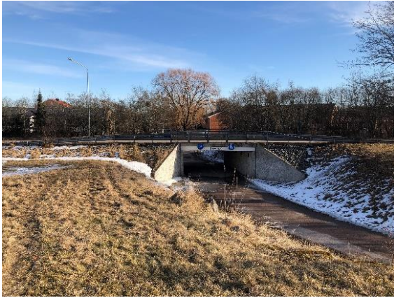
Förskoletomten till vänster i bild intill en gång- och cykelvägen som passerar under Flogstavägen i en tunnel
