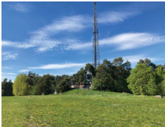
Figur 8 - Telekommasten som ligger norr om planområdet.
