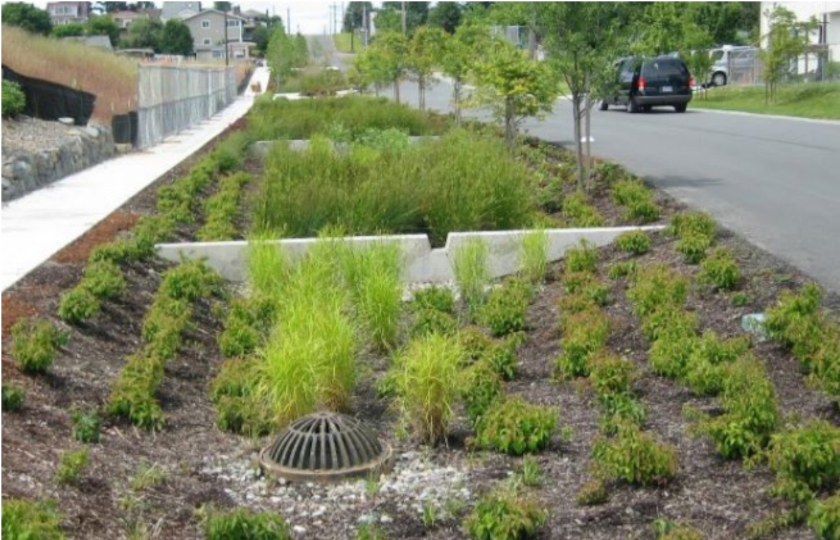
Figur 16, exempel på utförande av nedsänkt regnväxtbädd, (Holeman landscape, 2015)
