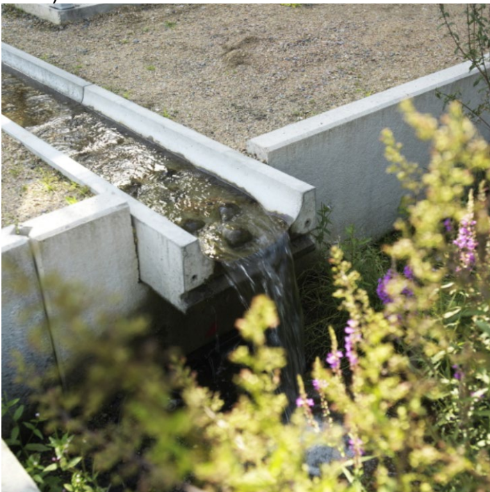
Figur 17, exempel på anslutning av rännalsplatta till nedsänkt regnväxtbädd i mark.
