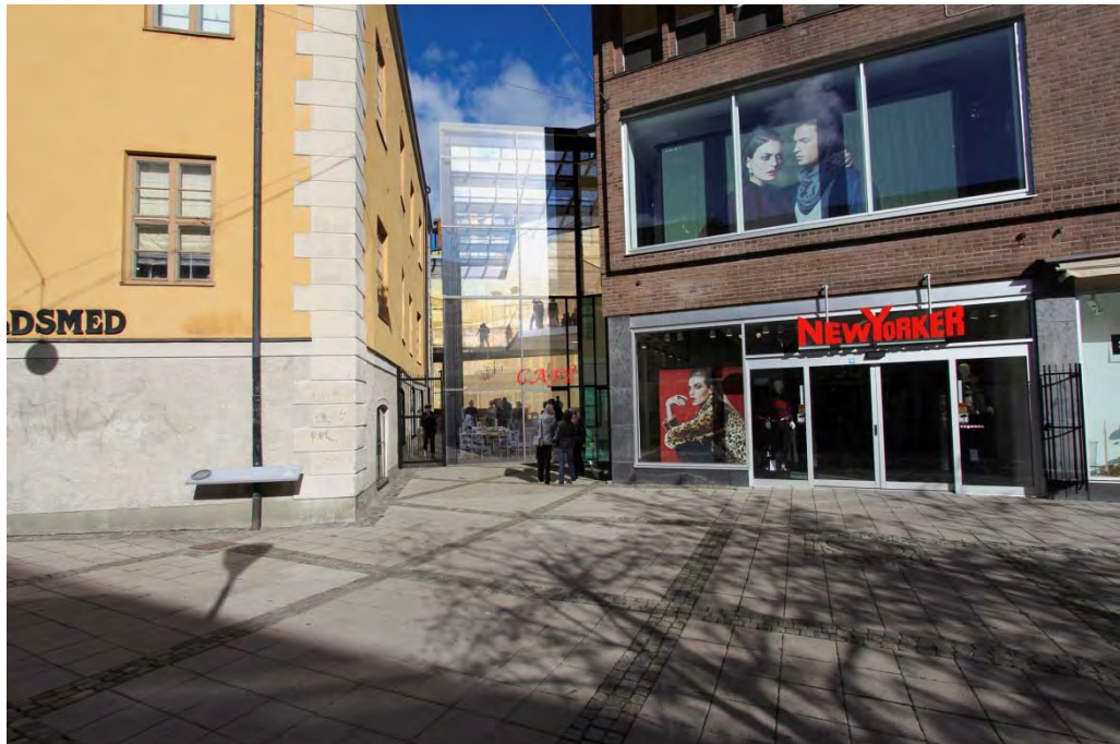
Möte Celsiushusets södra fasad, exteriör, förslagsskiss Sweco 2013-12-20
