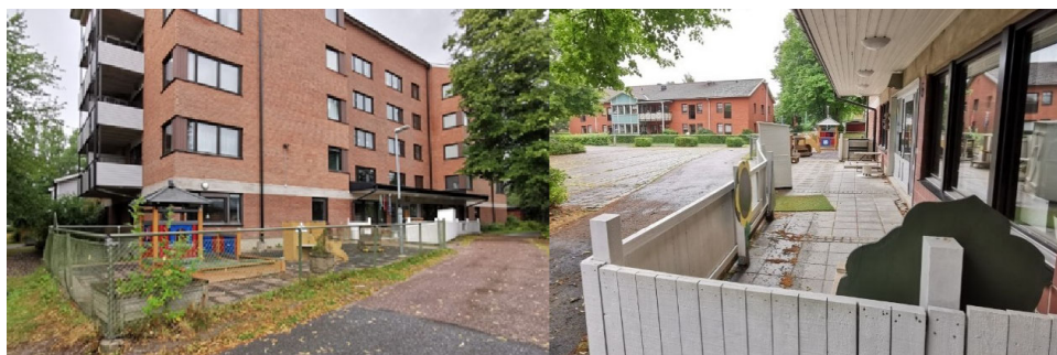
Bild 19 Nuvarande inhägnad av allmän plats i anslutning till förskolan inom fastigheten Flogsta 40:1.
