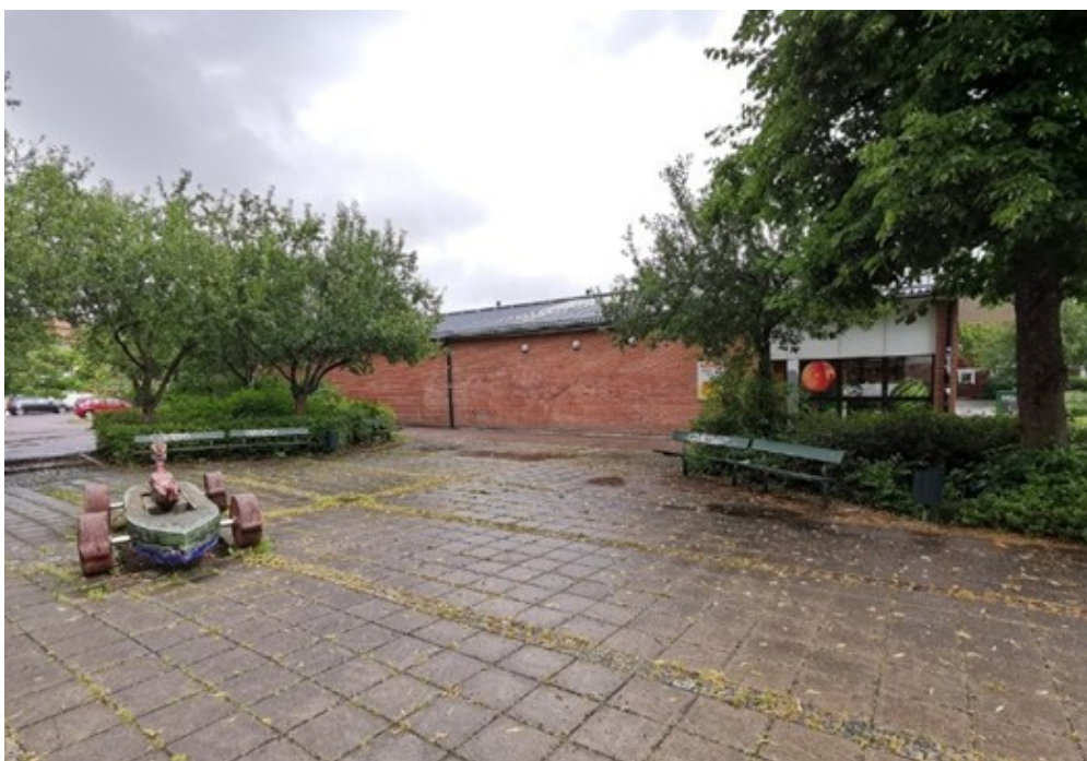
Bild 8 Butiksbyggnadens fasad som vetter mot torget. Till höger skymtas en del av entrén med ingång från gaveln (ej mot torget).
