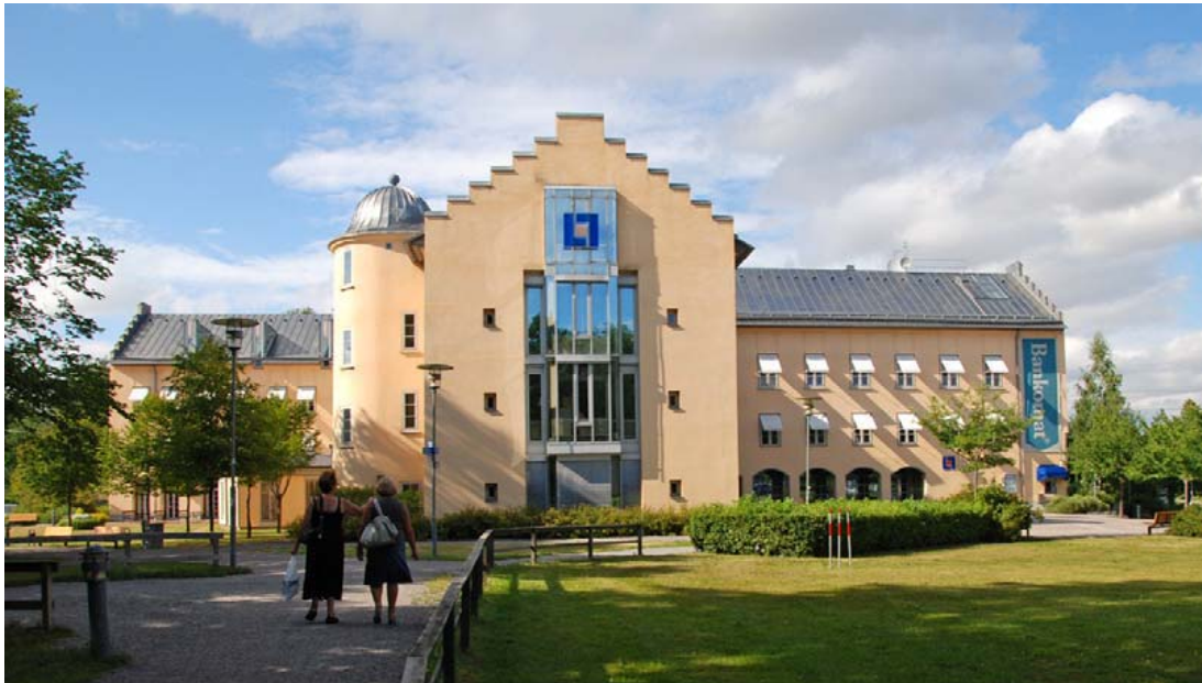
F.d. Hästens skofabrik efter ombyggnaden 1994, fasad mot söder. Nya trappstegsgavlar, uppglasade murpartier, arkader och smala fönsterkupor är resultat av ombyggnaden.
