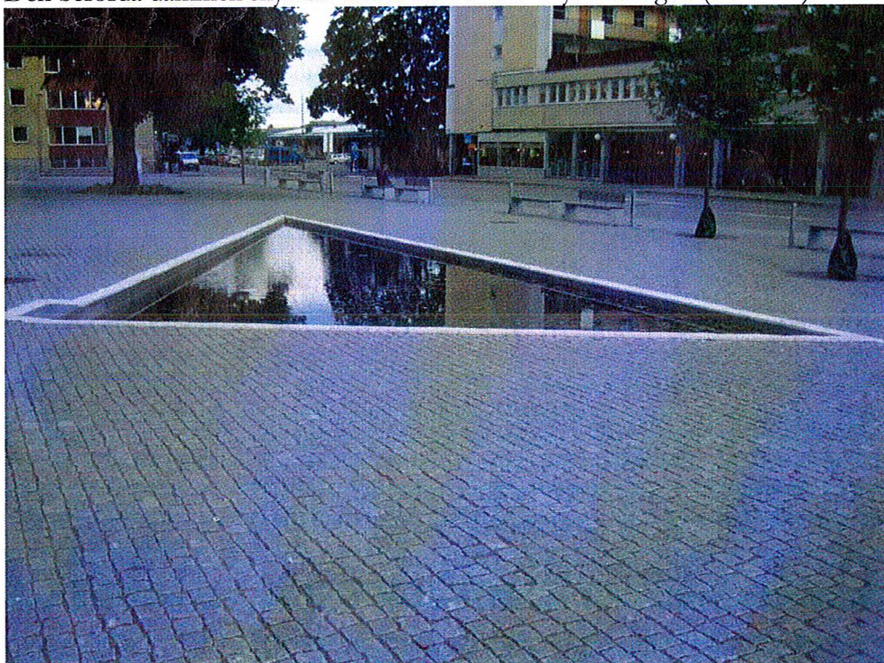
Dammen är numera försedd med en vitmarkerad och upphöjd kant efter kritik från synskadade.
