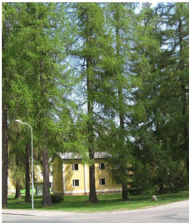
Figur 4.5.3 Riven byggnad (hus 56)
