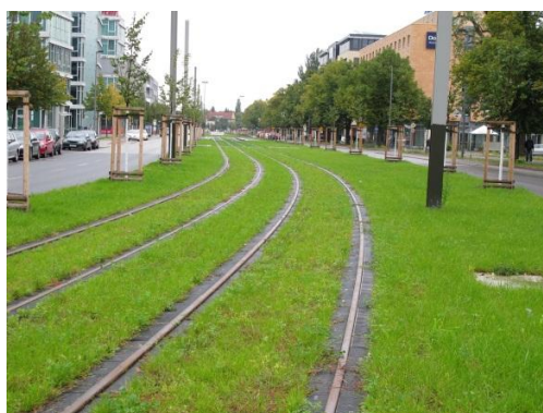
Figur 9. Spår i gräsarmering Tyskland.
