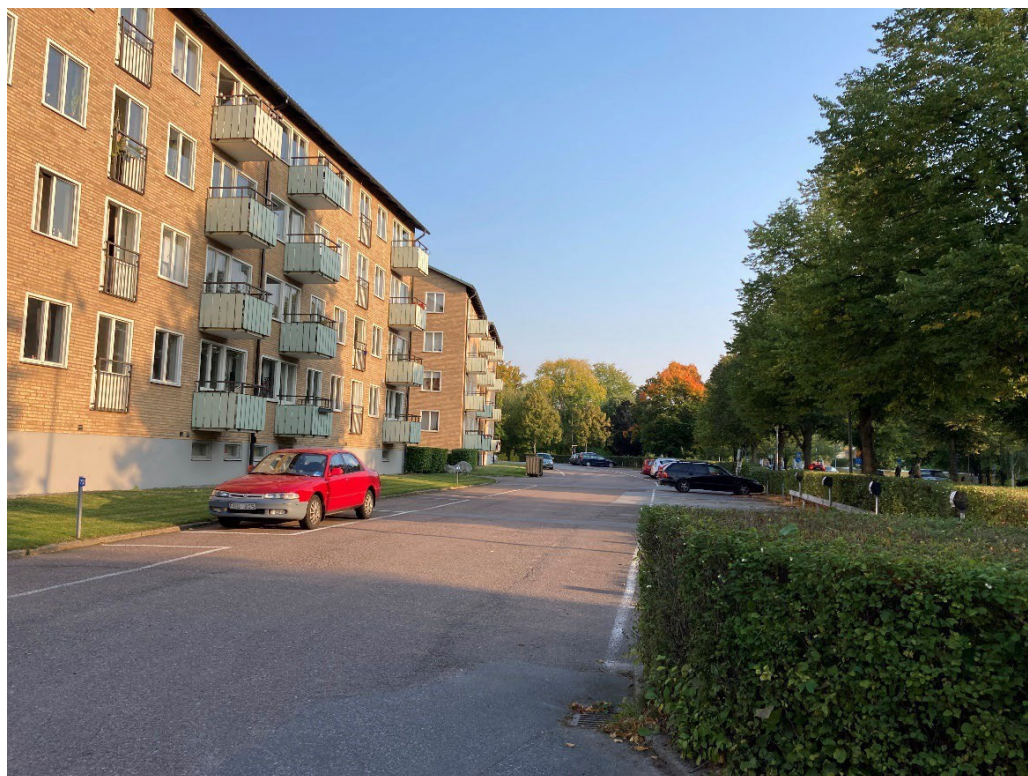
Bild 22 Foto på befintlig parkeringsplats längs med Krongatan.
