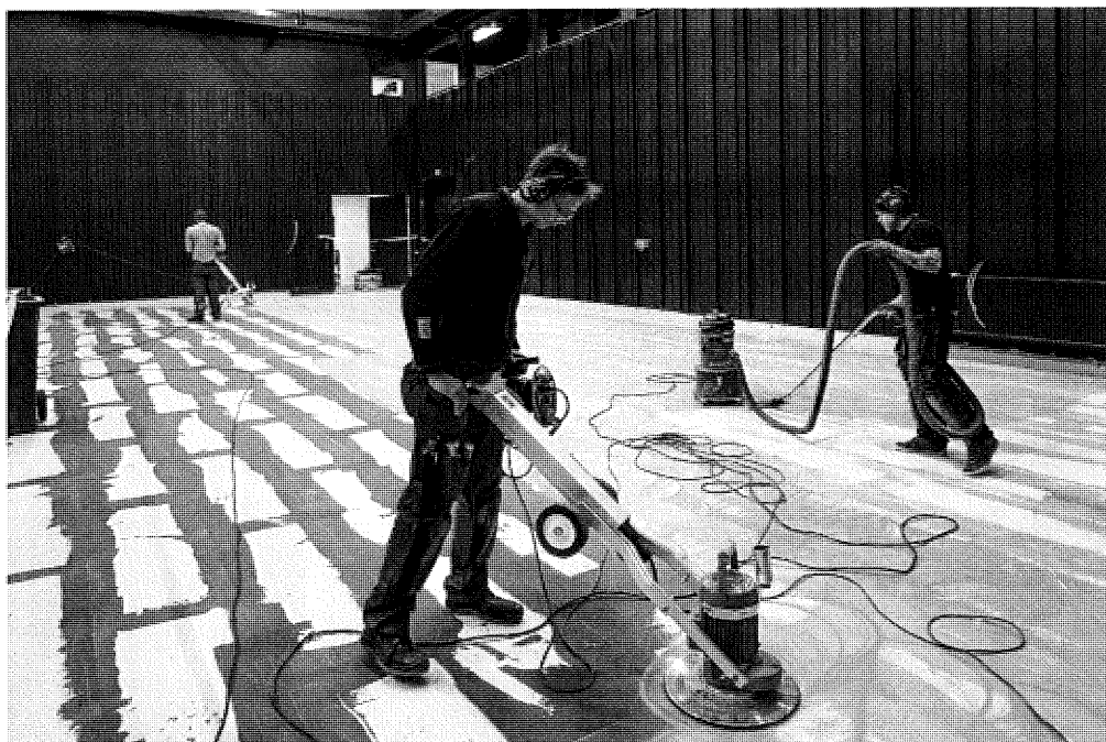
Byggnadsarbeten i den nya teatersalen i Gottsunda Kulturhus.
