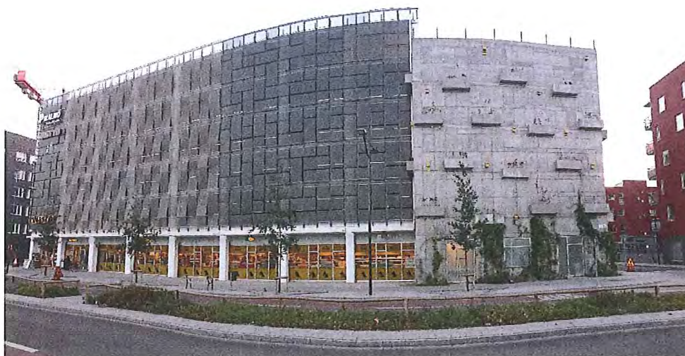
Figur 6-22. Parkeringshuset Fullriggaren i Malmö med en matbutik i markplan.
