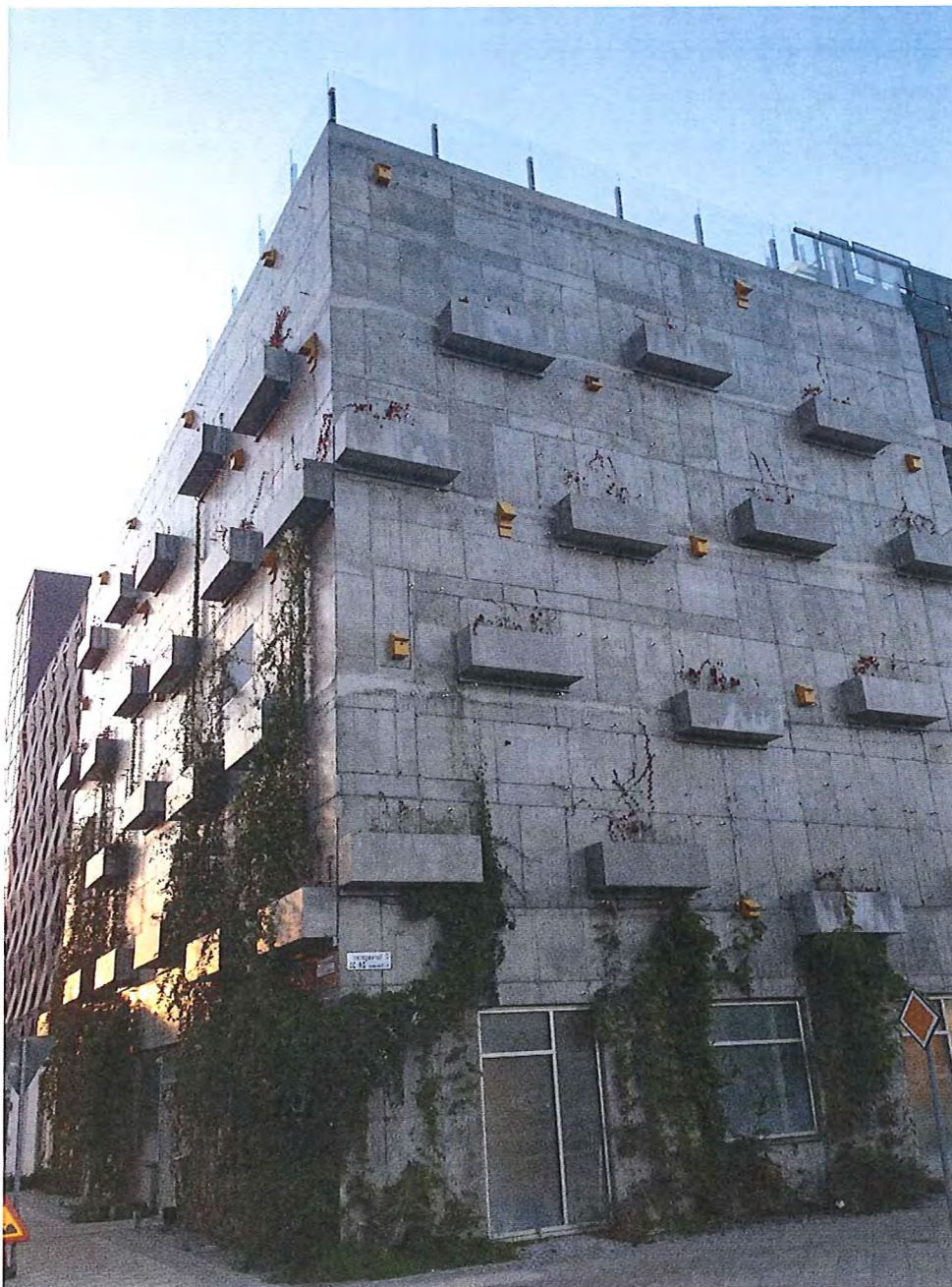
Figur 6-16. I Malmö har det nya parkeringshuset Fullriggaren delvis försett med en grön fasad.
