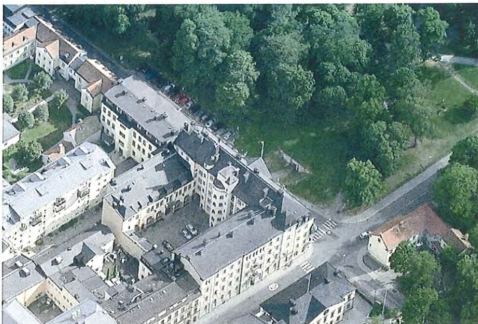
Figur 6-19. Skyddsrummet i Slottsbacken. Bildkälla: Bing Maps
