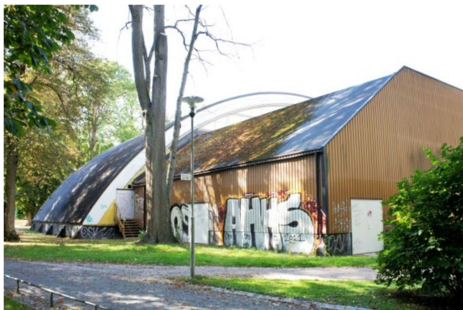
Bild 11 - Bollhusets baksida mot söder med den tillbyggda tennishallen från 70-talet, Wenanders Byrå, 2013.
