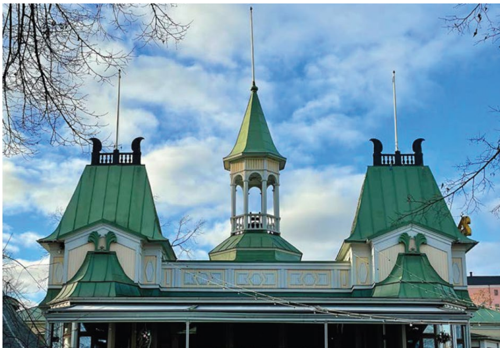
Bild 4 - Flustrets karaktäristiska taksiluett med hörntorn och mittorn. Dekor är både original och återskapad i form av bland annat listverk, balustrader, fyllningsmarkeringar, ljusramp och akroterier på tornhuvorna, Libeck antikvarie.
