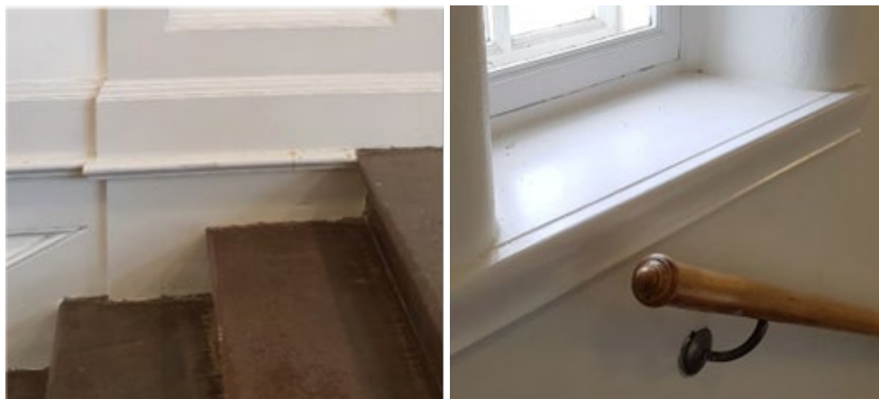
Bild 8 och Bild 9 - Bilden till vänster visar detalj på trappa och profilerad vägg i huvudtrapphuset. Bilden till höger visar räckesdetalj och fönsternisch i sekundärtrapphuset. White.
