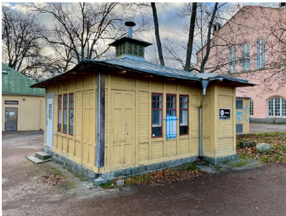
Bild 5 - Klosettbyggnaden med sin tidsenliga exteriör. Ventilationshuv kan kopplas till byggnadens tidigare funktion, Libeck antikvarie.
