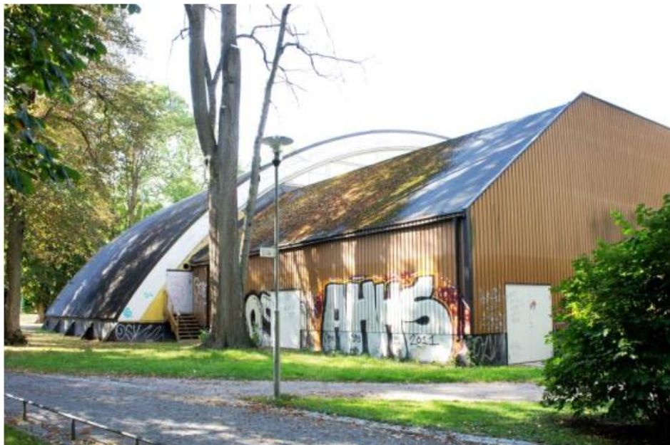
Figur 10. Bollhusets baksida i Söder med den motbyggda stålballen i förgrunden. (Foto: Wenanders Byrå, 2013)
