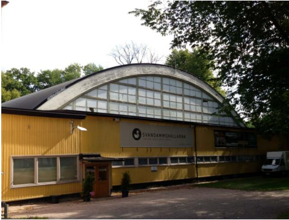
Figur 9. Bollhusets framsida i Väster. (Foto: Stockholms Byggnadsantikvarier AB, 2013)
