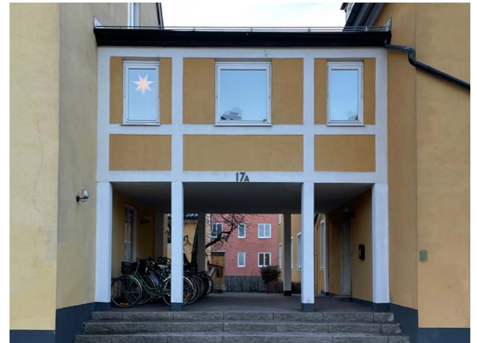
Från 1940-talets början och en bit framåt skedde stora förändringar i kvarteret Fågelsången som medförde att dess sydligaste del idag har en mer modern karaktär.
