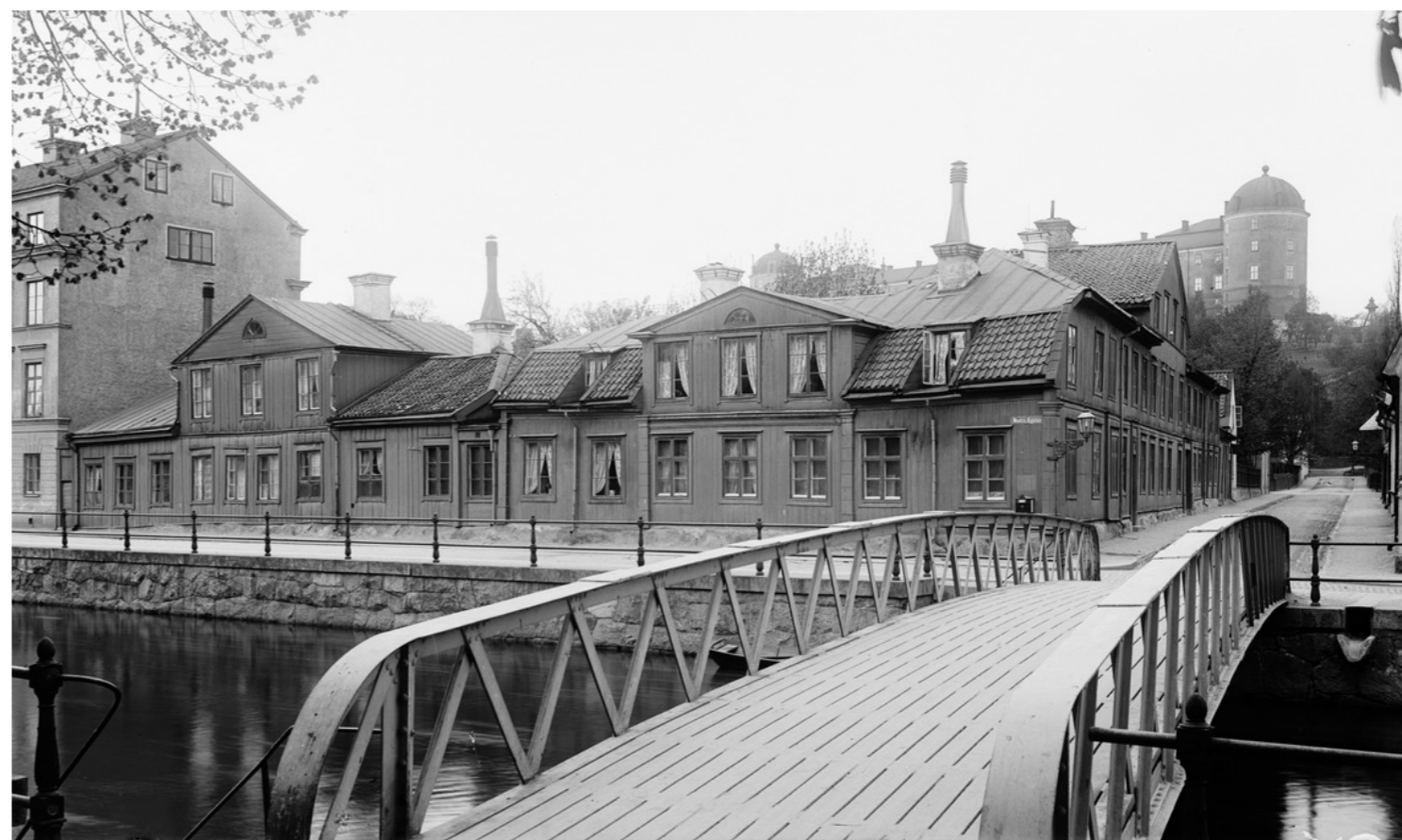
Låga trähus i norra hörnet av kvarteret Munken, tillkomna i omgångar under 1800-talet. Husen, som kallades Imperfectum, revs 1965. Sedermera byggdes Katolska kyrkan här. I förgrunden Västgötaspången. Foto Paul Sandberg. Upplandsmuseet.
