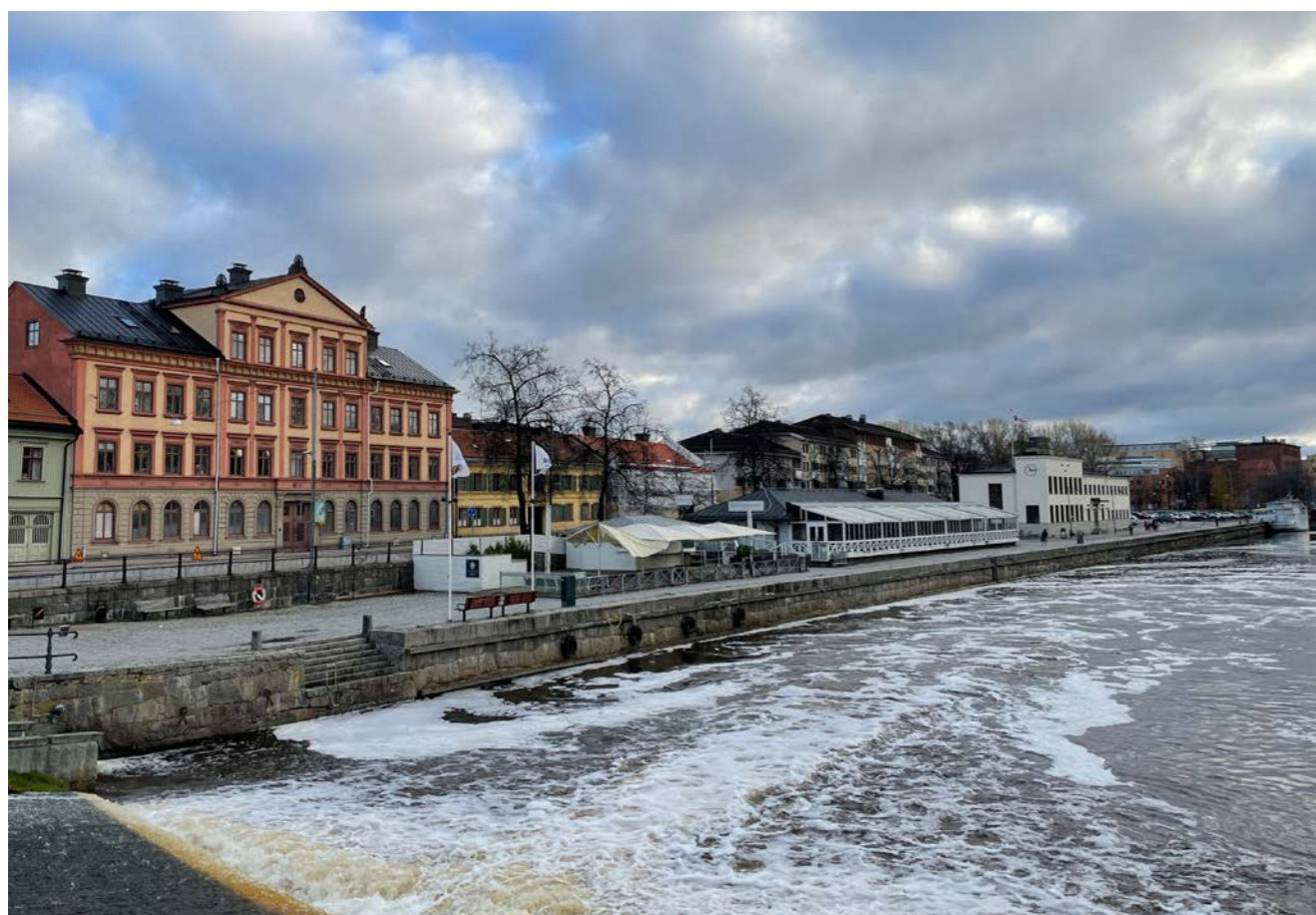
Hamnen sedd från Islandsbron. Till höger syns det tullhus Gunnar Leche ritade vid mitten av 1930-talet. Restaurangbyggnaden har sin grund i de magasin som uppfördes för hamnverksamheten.
