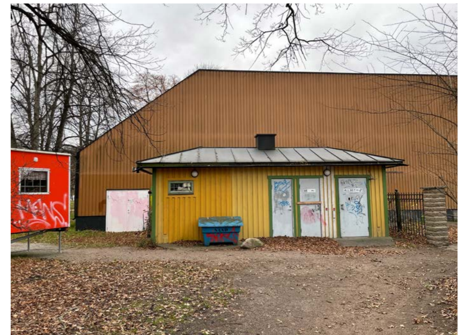
Offentlig WC-byggnad som är placerad mellan Flustret och Bollhallen.
