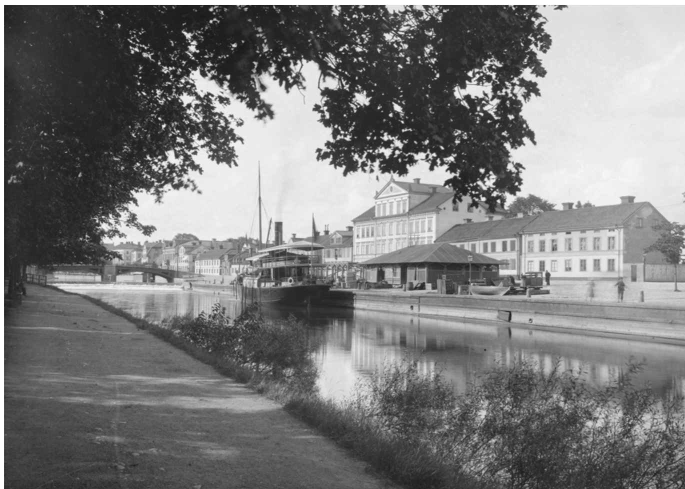
Vid slutet av 1800-talet utgjordes bebyggelsen söder om Bangårdsgatan fortfarande av relativt låga hus. Ett undantag var det så kallade Vershuset intill hamnområdet. Bilden togs enligt uppgift den 14 juli 1889. Foto Henri Osti. Upplandsmuseet.
