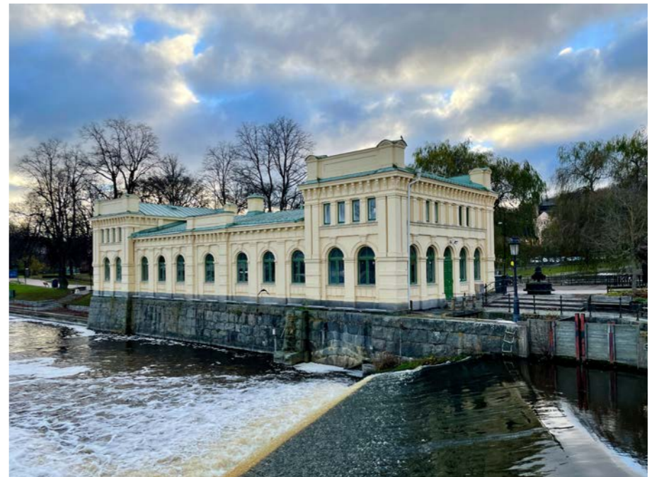
Den äldsta delen av Pumphuset vid Islandsfallet härrör från 1875 då Uppsala första vattenverk invigdes. 1900–01 skedde en större utbyggnad. Till höger kan vad som troligen var intaget till turbinen anas. Vid vattenlinjen nedanför fallet anas en välvd utloppsöppning.
