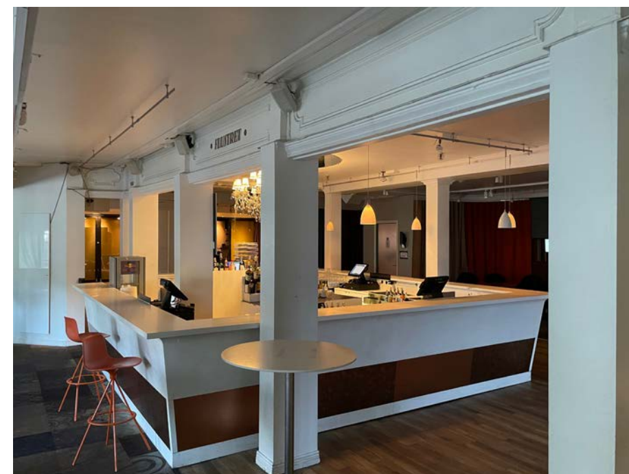
Bar på nedervåningen. Här kan den tidigare ytterväggen utläsas, med dekor utläsas genom de ingipsade stolparna.
