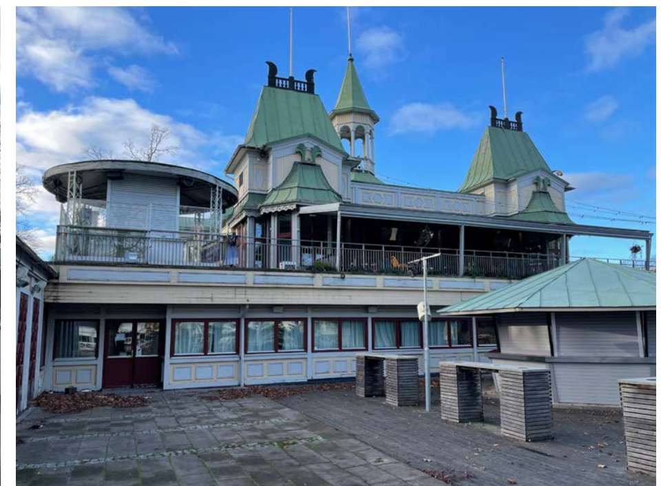
Flustrets huvudfasad med tillägg från 1980-talet och 2009. Ungefär på samma yta där det på 1950-talet anlades en damm finns idag en fristående barbyggnad. Marken är belagd med trätrall och betongsten med inslag av gatsten.
