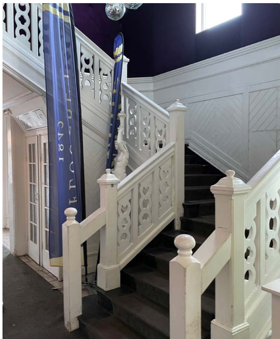
På 1870-talet tillkom trapphus på båda gavlarna. På 1920-talet byggdes trappan på norra sidan om, vilken delvis har bevarats
