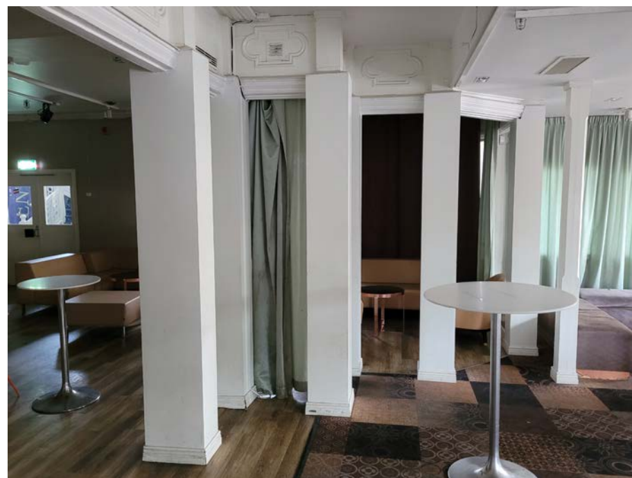
Del av nedervåningen där byggnadens tidigare fasadlinje mot öster kan utläsas genom de ingipsade stolparna.
