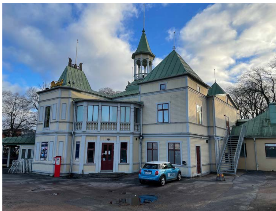
Bilden visar den tillbyggnad som gjordes mot väster i början av 1900-talet (framför bilen), med både liggande och stående panel. Jämfört med bygglovsritningen från 1900 har stora förändringar skett avseende fönster och dörrar.
