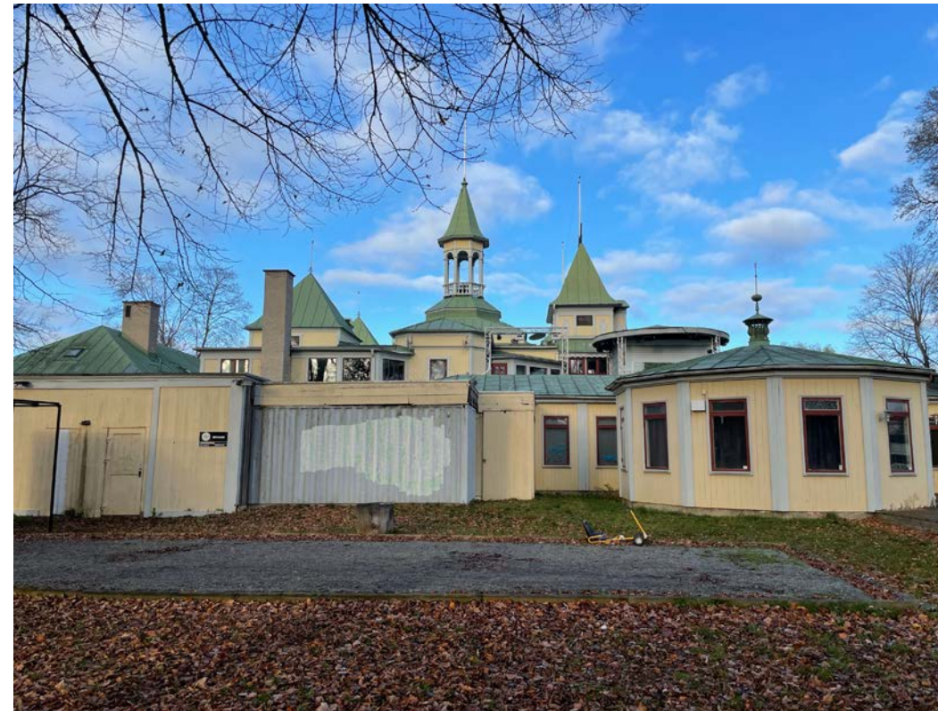
Ovan till vänster: Köksbyggnaden utmärker sig genom sin putsade fasad. Vindsvåningen inreddes på 1950-talet för personalutrymmen.
