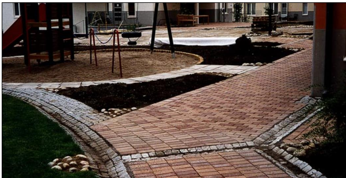
Figur 5-2. Exempel på avledning av takvatten via ränndalar anlagda med gatsten (Källa: Stockholm Vatten AB, n.d.).
