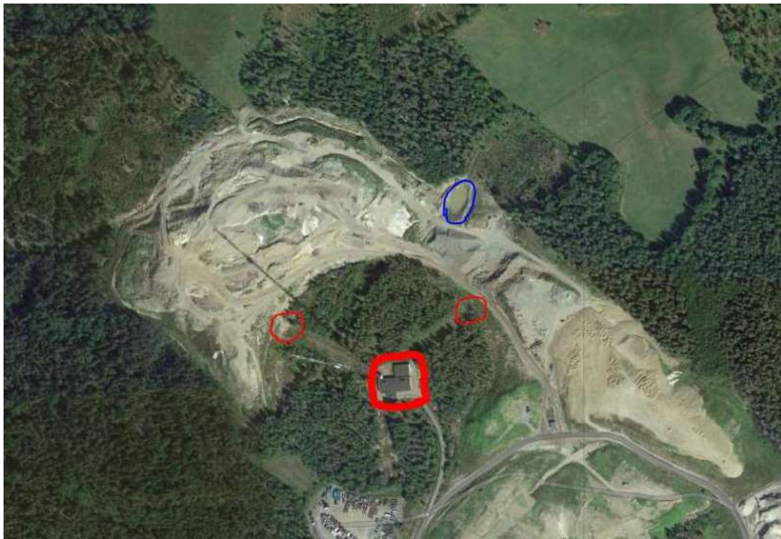
Figur 3-1 Signalmast med tillhörande berörda stag (röd färg) och befintlig dagvattendamm (blå cirkel).
