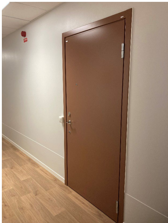
Figur 2: Exempel på en hög avbärarlist som påkörningsskydd som skapar ett hemligt intryck, källa Uppsala kommun.
