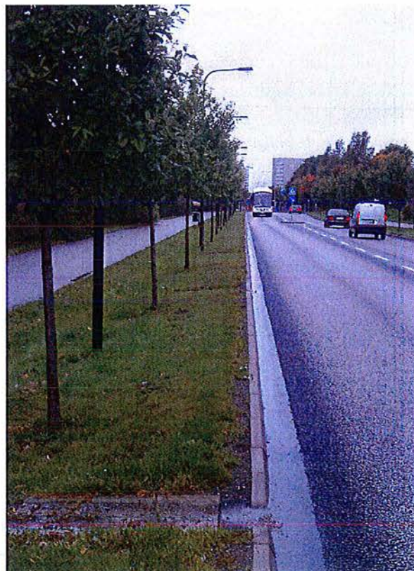
Trädplanterad grönyta skiljer den högräskade gatan från gång- och cykelvägen. Exemplet visar också hur dagvatten från gatan avleds till infiltrationsyta.
