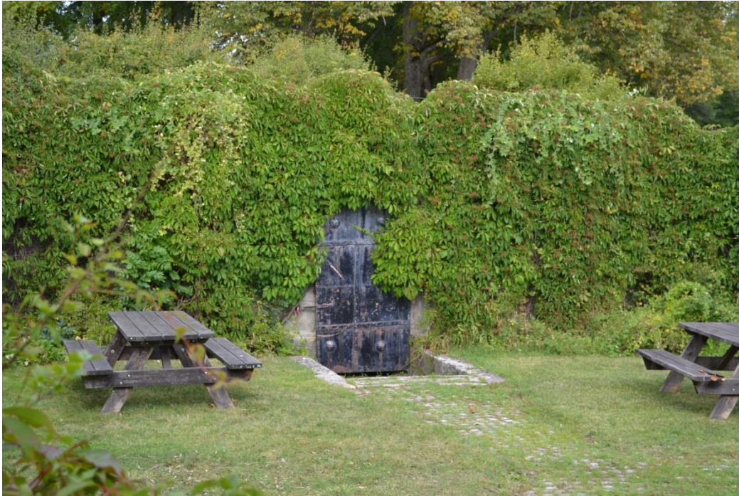
Bild 31. Entré till jordkällare.
