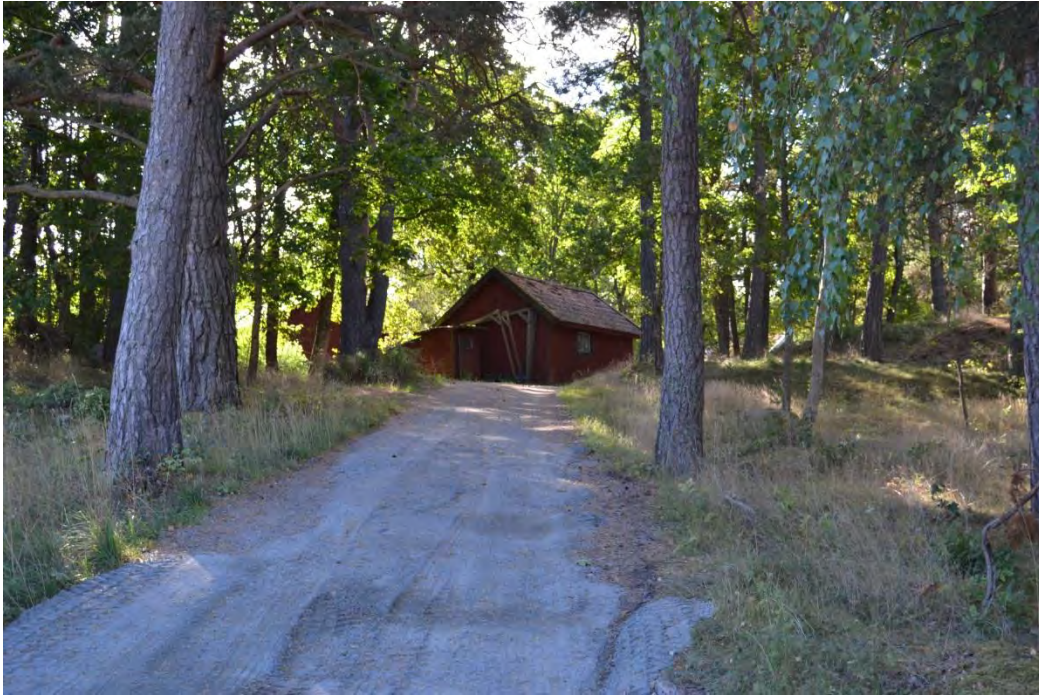
Bild 64. Garage/fårhus sett från söder, från vägen.
