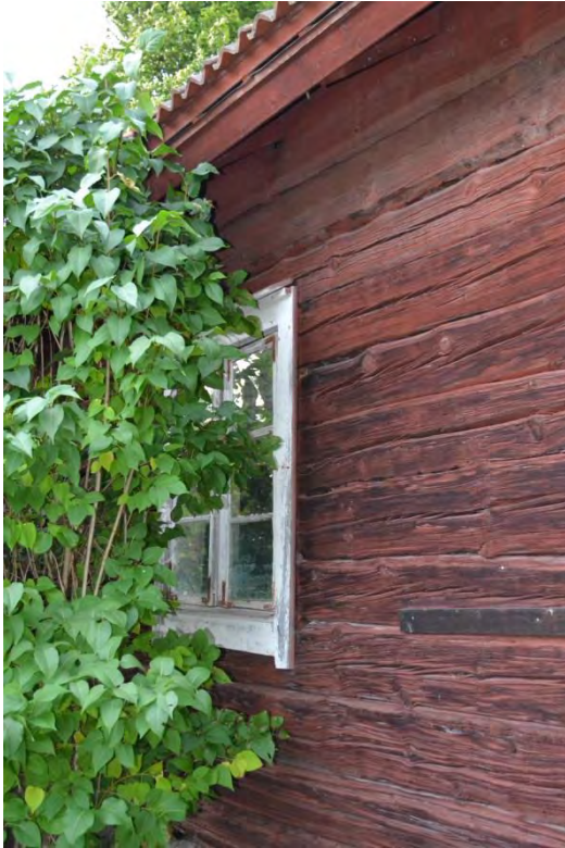
Bild 114. Ånnesta sommarstuga sett från söder. Liggtimmersektion.
