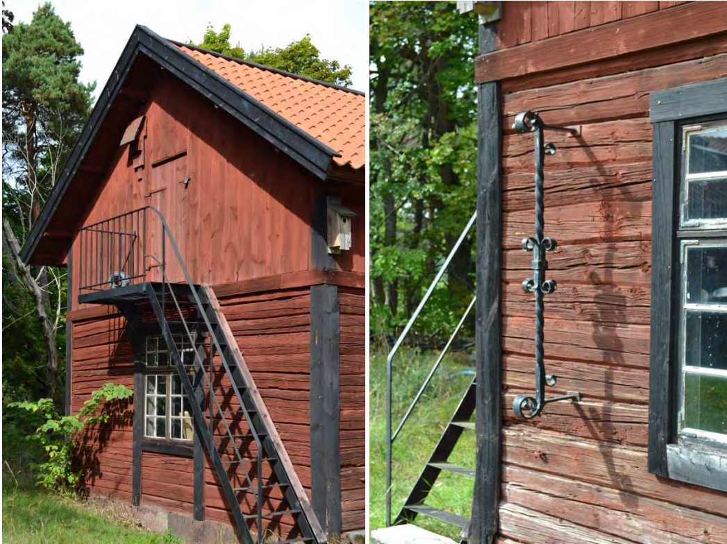
Bild 46. Smedja, trapp til vind, söderfasad.
