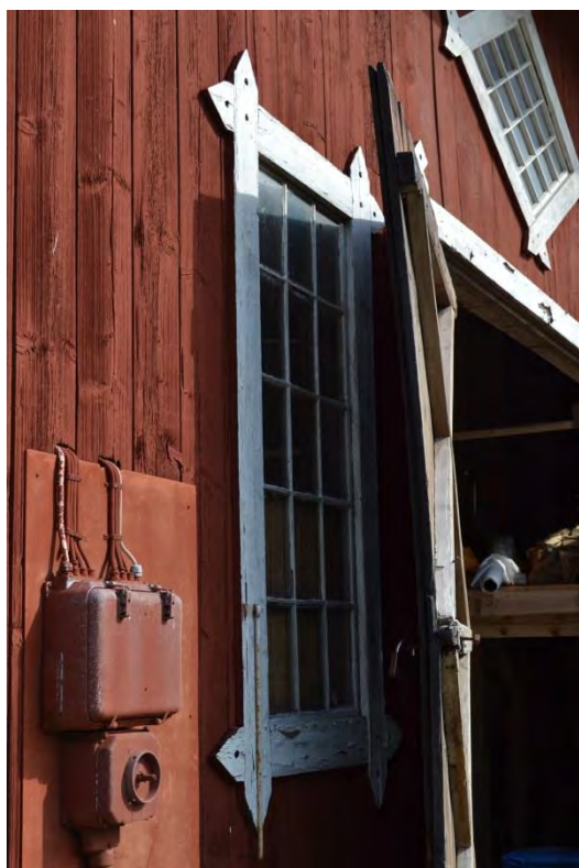
Bild 34. Detalj på fönster.
