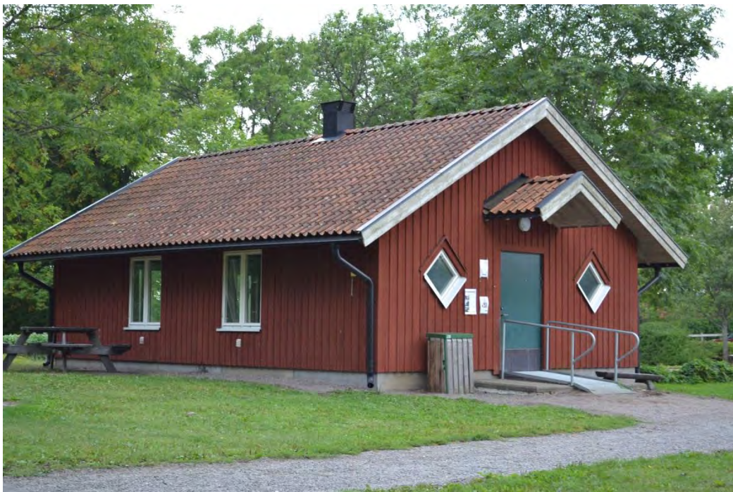
Bild 49. Raststuga fasad nordöst.
