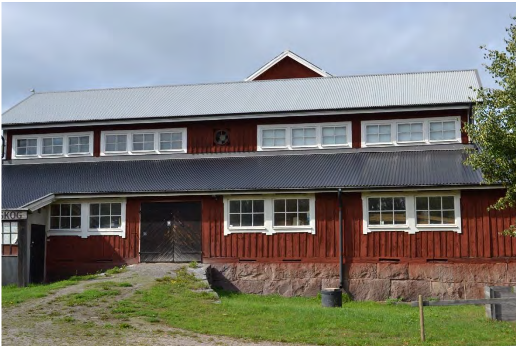
Bild 36. Snickeriets östra fasad.
