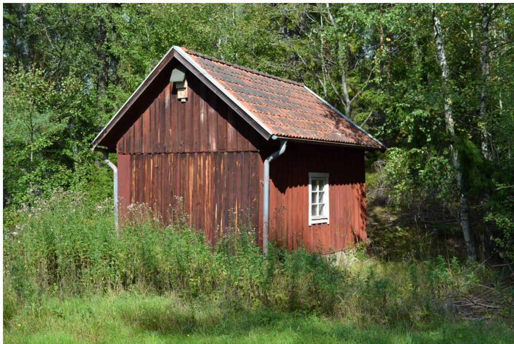
Bild 79. Fyristorpets före detta höns hus. Väster och öster fasad. Lägg märke till missfärgning väster fasadsida.
