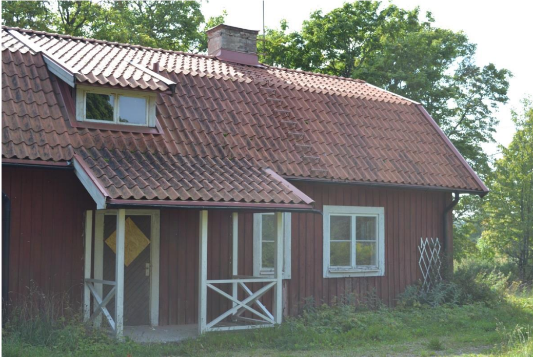
Bild 56. Entré till väster lägenhet.
