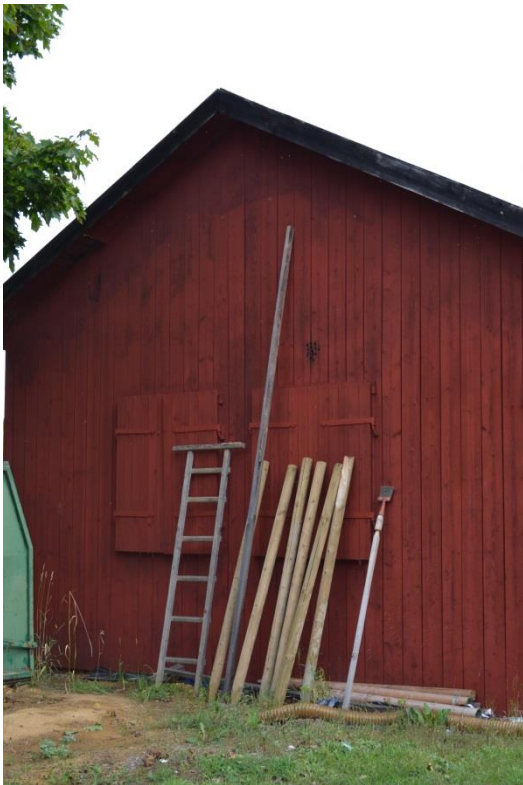
Bild 43. Traktorgarage/lider fasad mot väster
