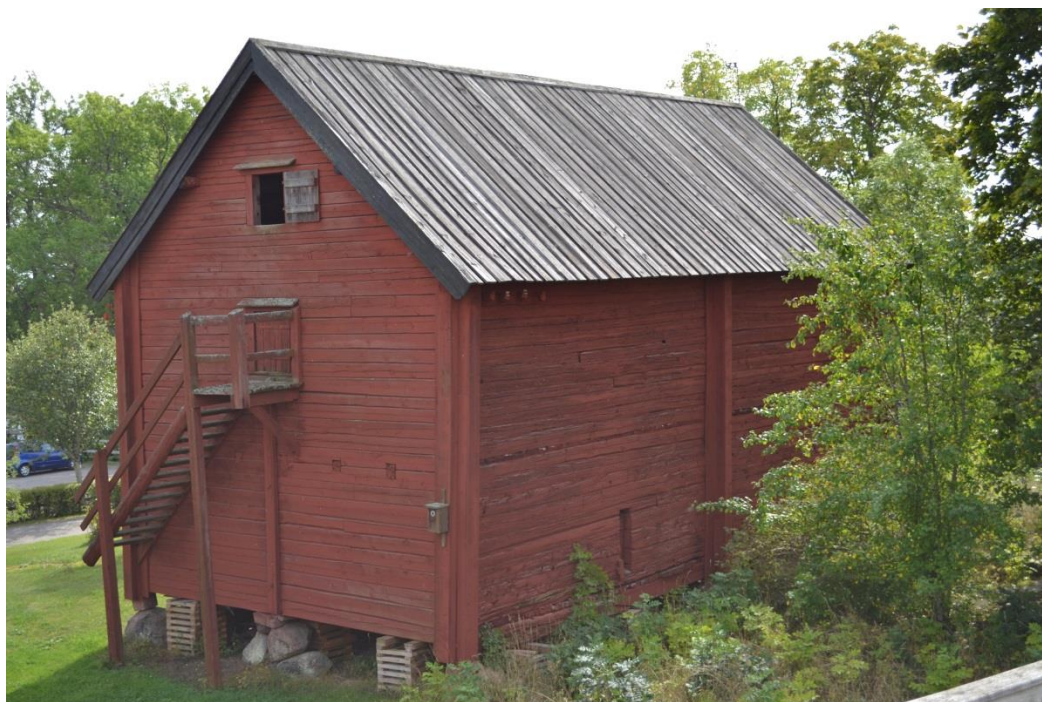
Bild 40. Magasinsbyggnad sedd från nordväst.
