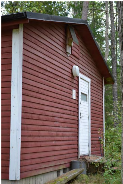
Bild 78. Fyristorps bastubyggnad, nordlig fasad.
