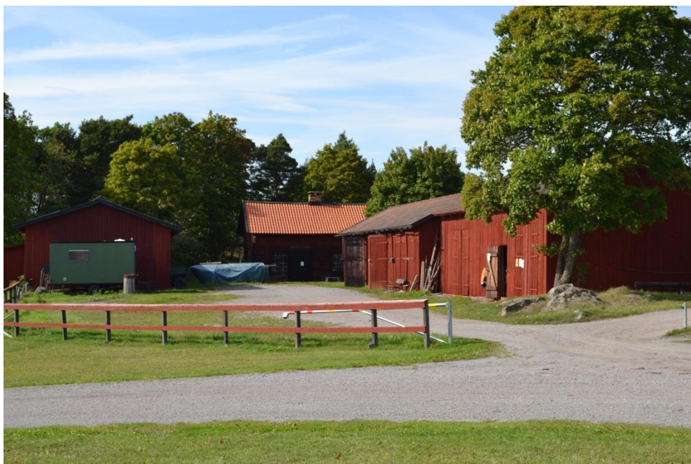
Bild 4. Från vänster: Redskapslider, smedja & traktorgarage sett i västlig riktning.
