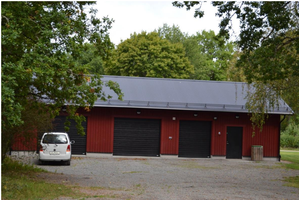
Bild 65. Varmgaragets södra fasad.
