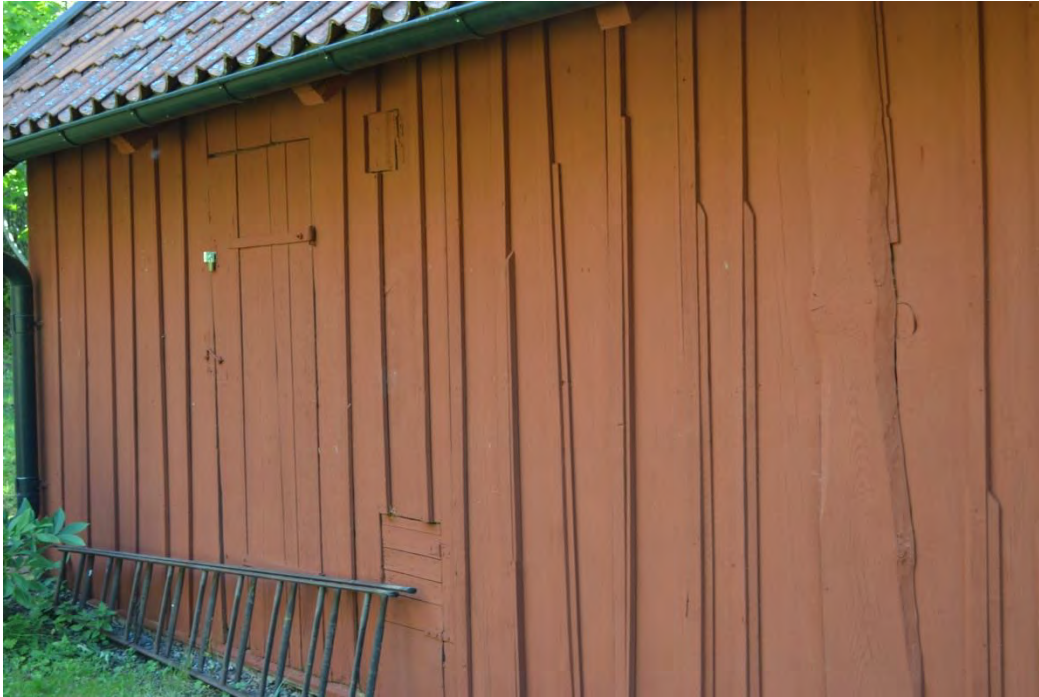
Bild 83. Humlegården. Detalj panel och förrådsdörr.
