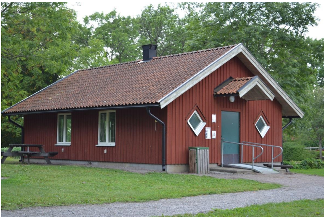
Bild 49. Raststuga fasad nordöst.
