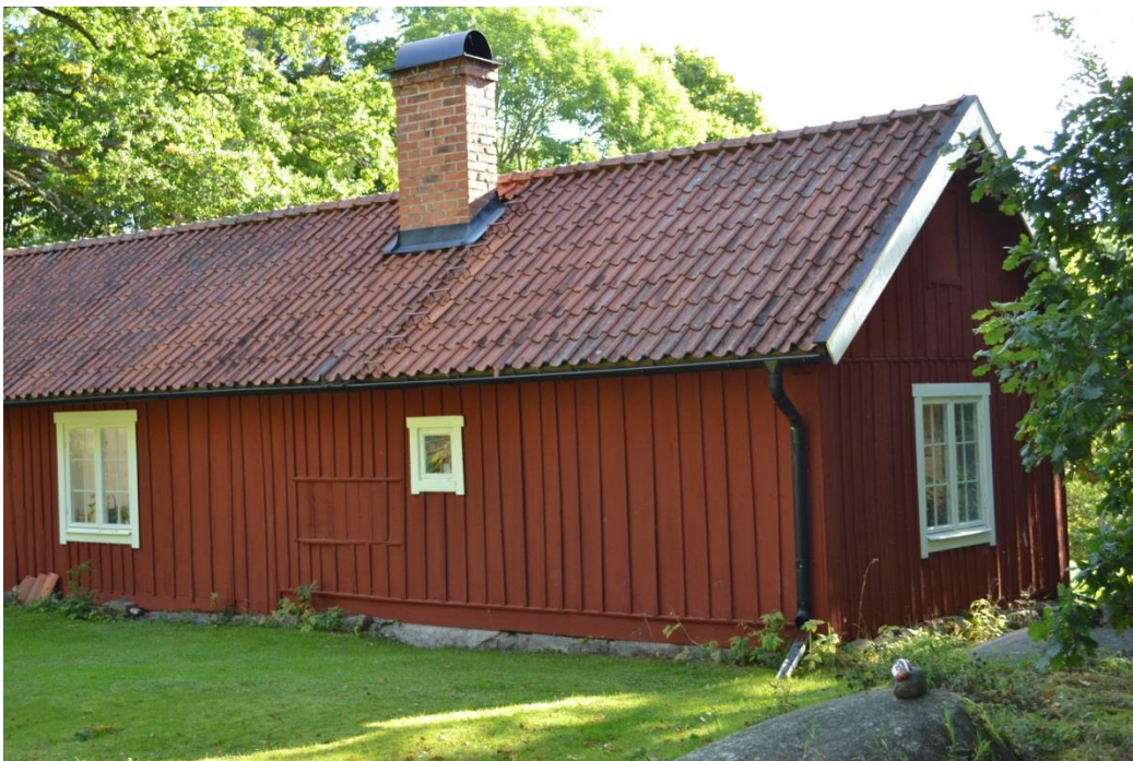
Bild 82. Humlegården väster fasad. Lägg märke till panelens olika utförande.
