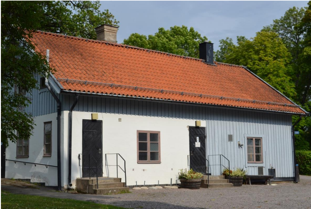
Bild 29. Garage/toaletbyggnad sedd från sydväst.
