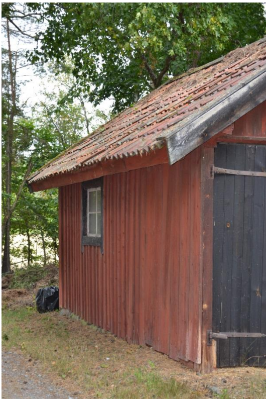
Bild 63. Garage/fårhus väster fasad.
