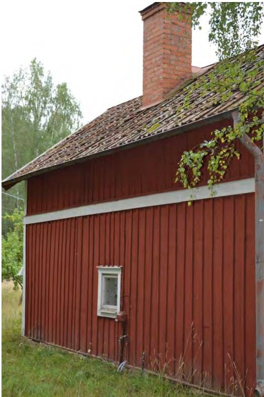
Bild 75. Fyristorp, nordöstlig fasad.
