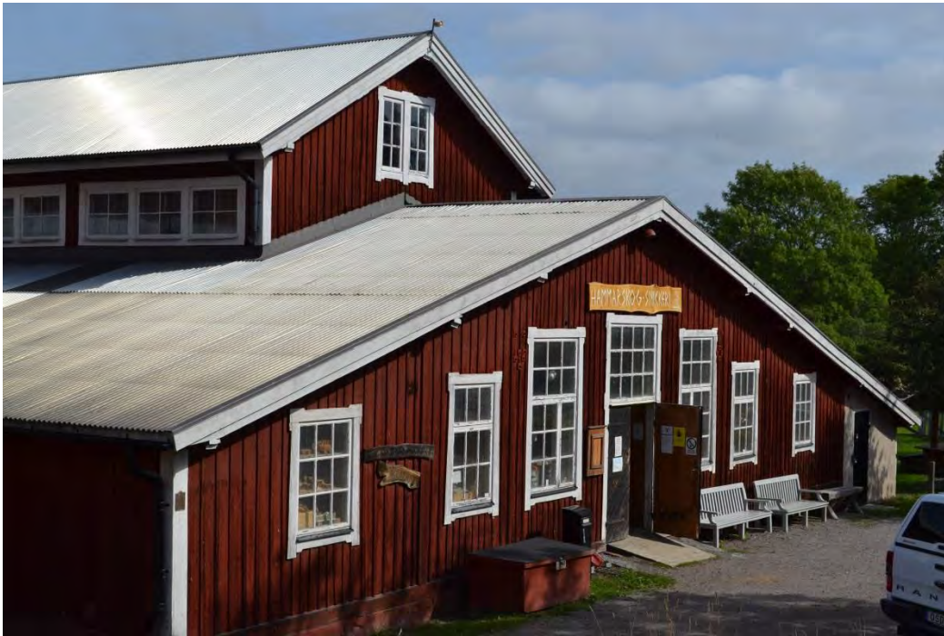
Bild 35. Snickeriets södra fasad.
