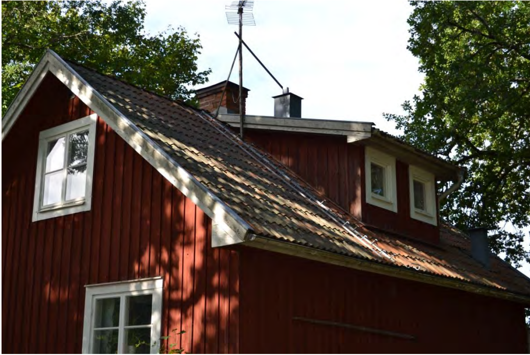
Bild 90. Björkbacken. Fönstergenombrott i tak. Nordlig fasad.
