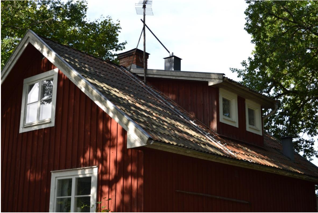
Bild 90. Björkbacken. Fönstergenombrott i tak. Nordlig fasad.
