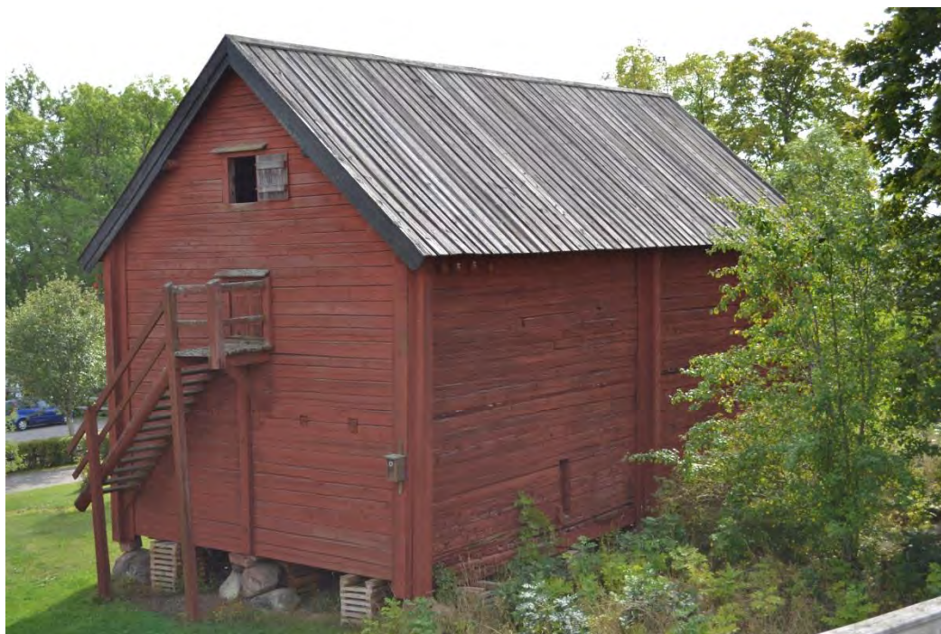
Bild 40. Magasinsbyggnad sedd från nordväst.
