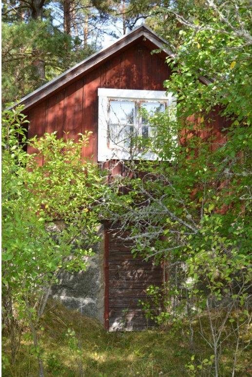
Bild 76. Fyristorps jordkällare med överbyggnad. Fasad sydväst.
