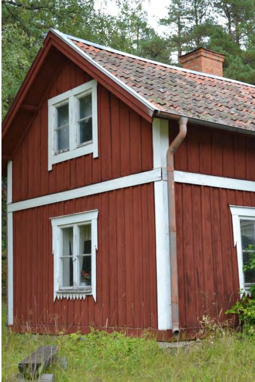
Bild 74. Fyristorp, nordvästlig fasad.
