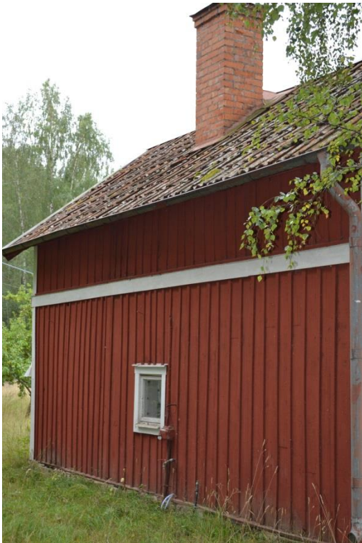
Bild 75. Fyristorp, nordöstlig fasad.
