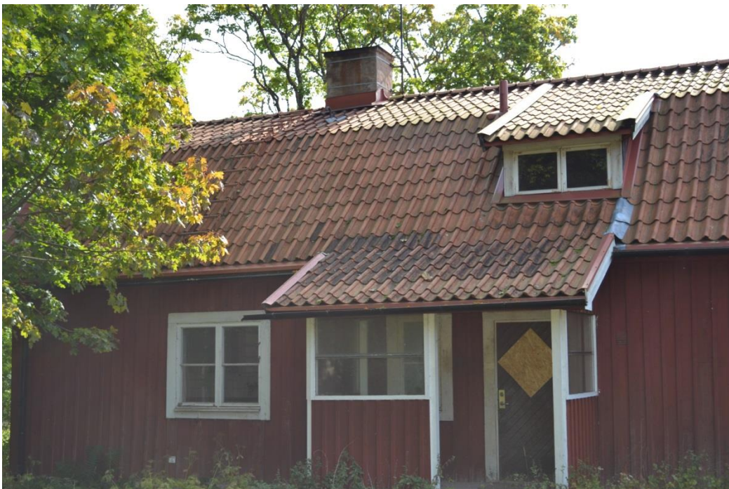
Bild 57. Entré till öster lägenhet.
