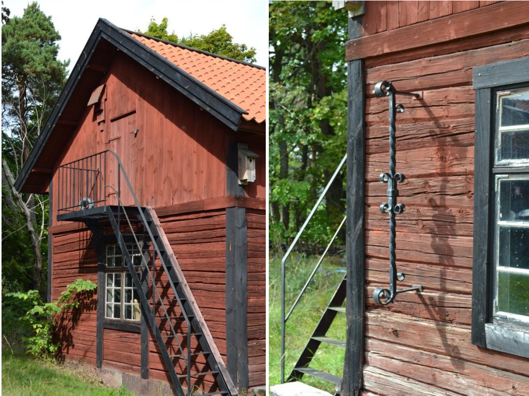
Bild 46. Smedja, trapp til vind, söderfasad.
