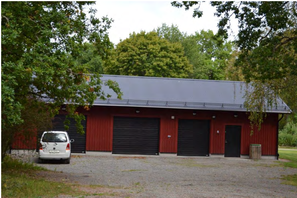
Bild 65. Varmgaragets södra fasad.
