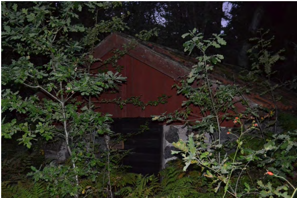
Bild 53. Persborgs jordkällare, entré, fasad mot norr.
