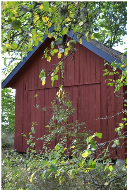
Bild 86. Humlegårdens uthus, fasad mot norr.
