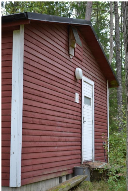
Bild 78. Fyristorps bastubyggnad, nordlig fasad.
