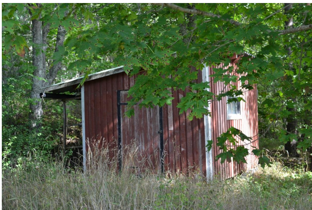
Bild 59. Hammarbys Förrådshus, sett från sydväst.
