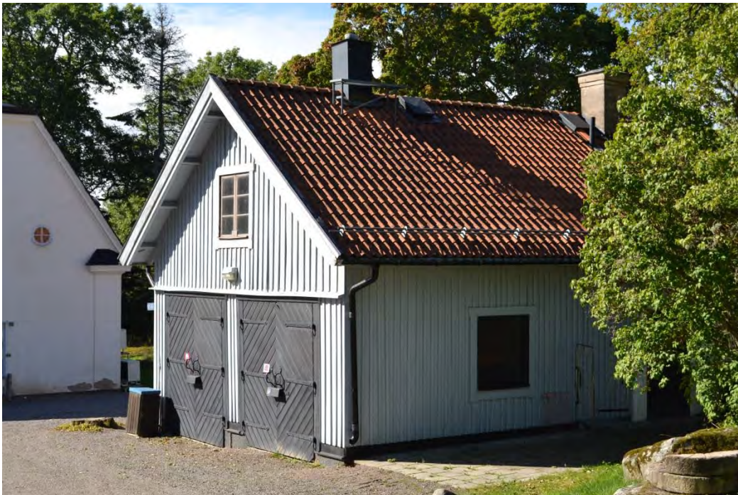
Bild 30. Garage/Toaletbyggnad sedd från nordöst.
