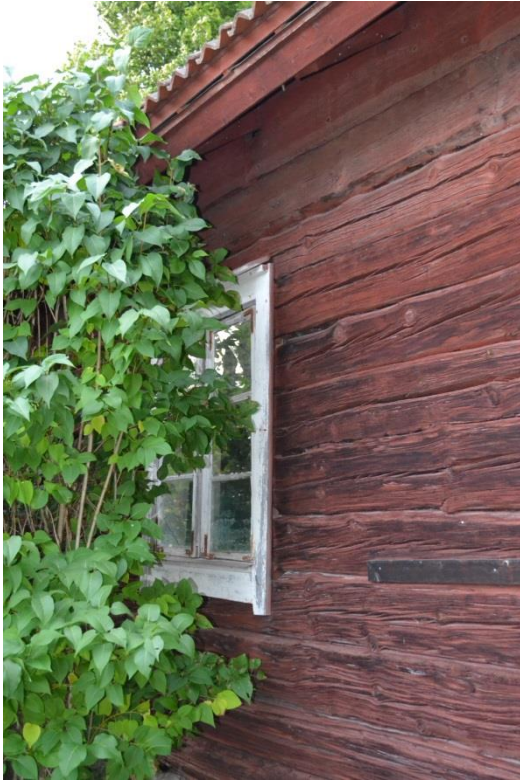
Bild 114. Ånnesta sommarstuga sett från söder. Liggtimmersektion.
