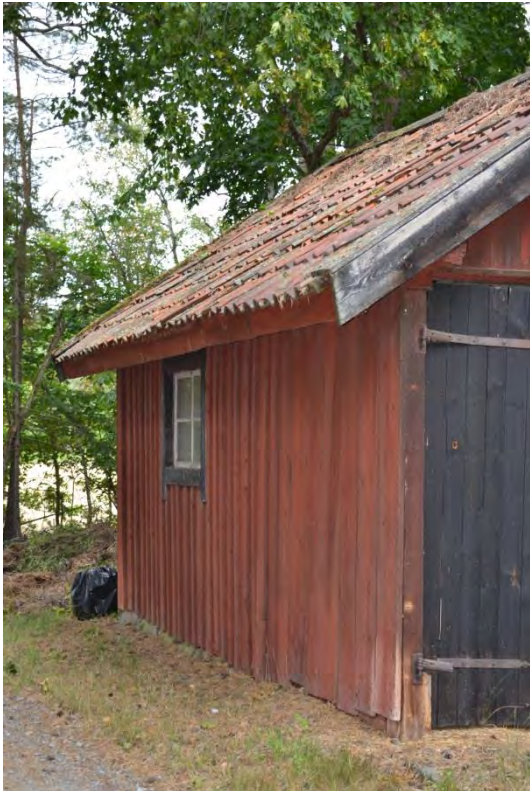
Bild 63. Garage/fårhus väster fasad.
