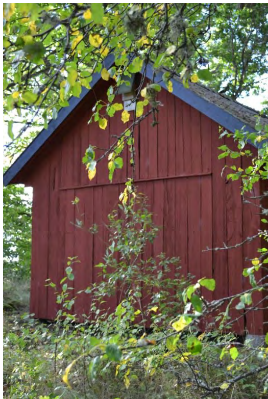
Bild 86. Humlegårdens uthus, fasad mot norr.
