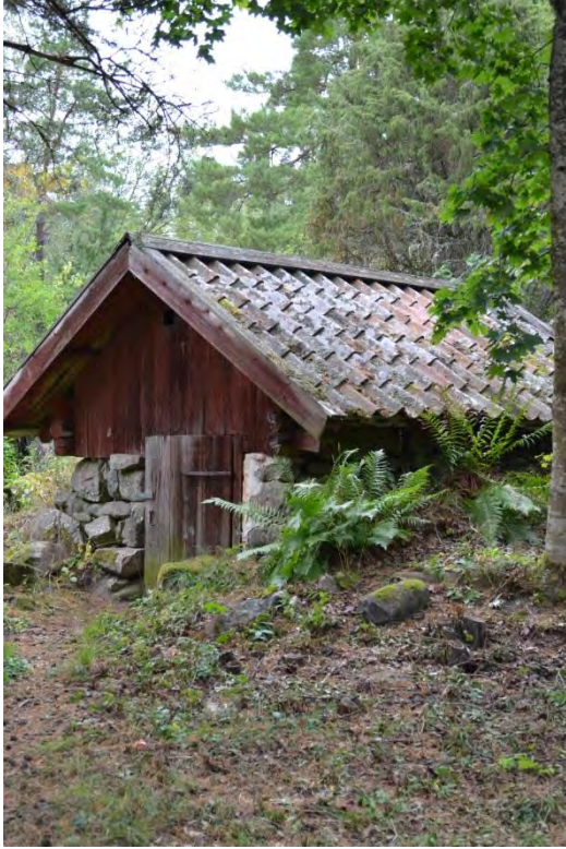
Bild 72. Östbergstorpets jordkällare sett från öster.
