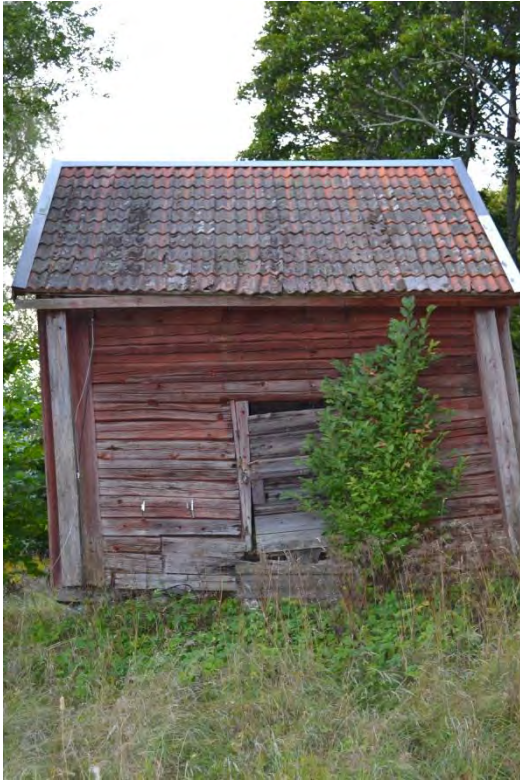
Bild 116. Ännesta magasinbyggnad/källarnattstuga. Öster fasad.
