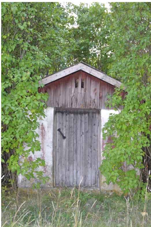
Bild 118. Ännesta pumphus. Väster fasad.
