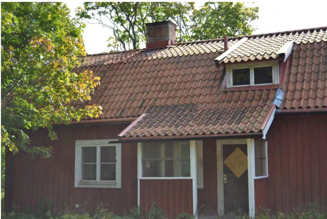
Bild 57. Entré till öster lägenhet.
