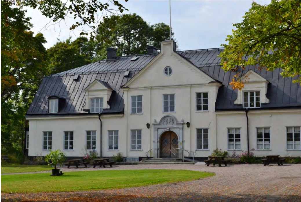
Bild 28. Öster fasad. På den södra fasaden kan man ana den utbyggnad som finns där.
