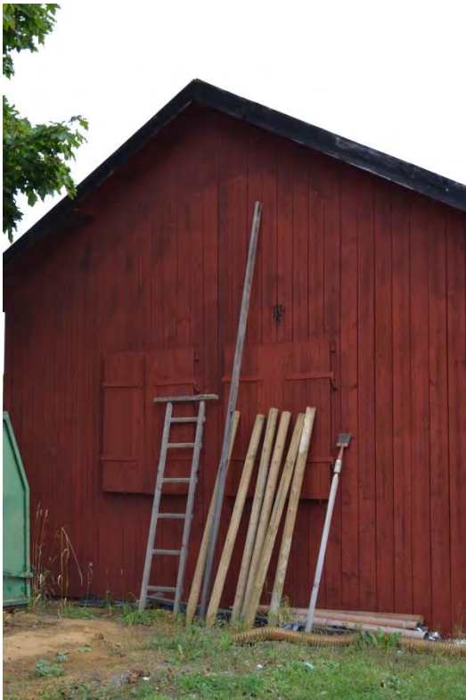
Bild 43. Traktorgarage/lider fasad mot väster
