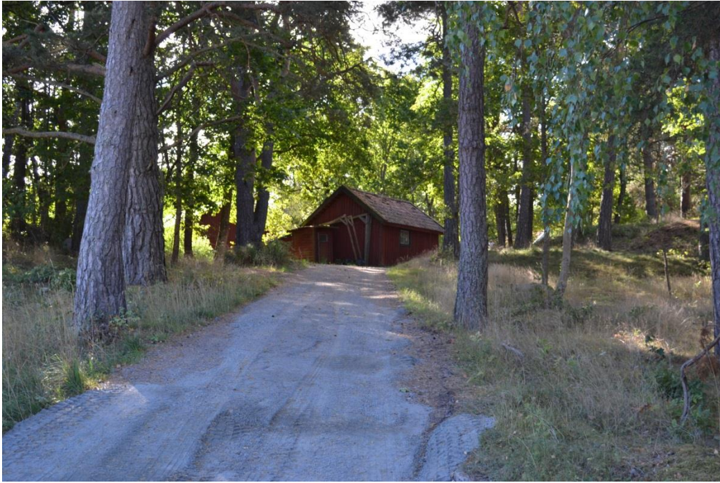
Bild 64. Garage/fårhus sett från söder, från vägen.
