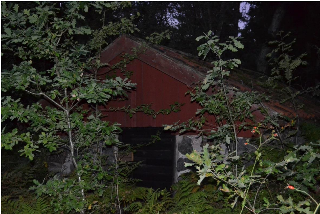
Bild 53. Persborgs jordkällare, entré, fasad mot norr.
