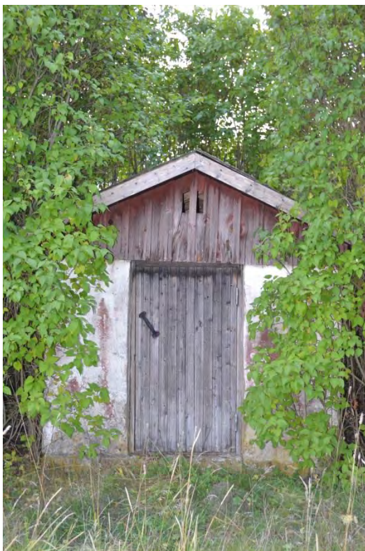
Bild 118. Ännesta pumphus. Väster fasad.
