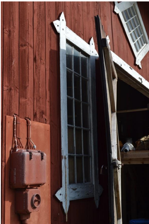
Bild 34. Detalj på fönster.
