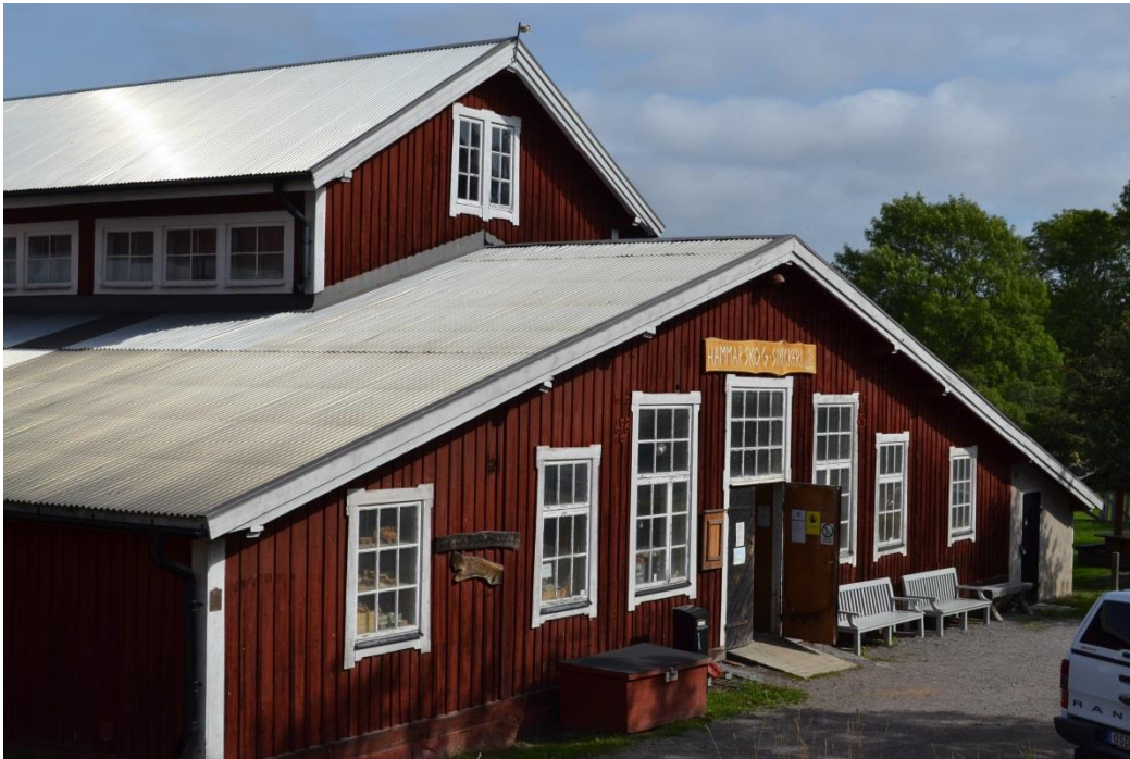
Bild 35. Snickeriets södra fasad.
