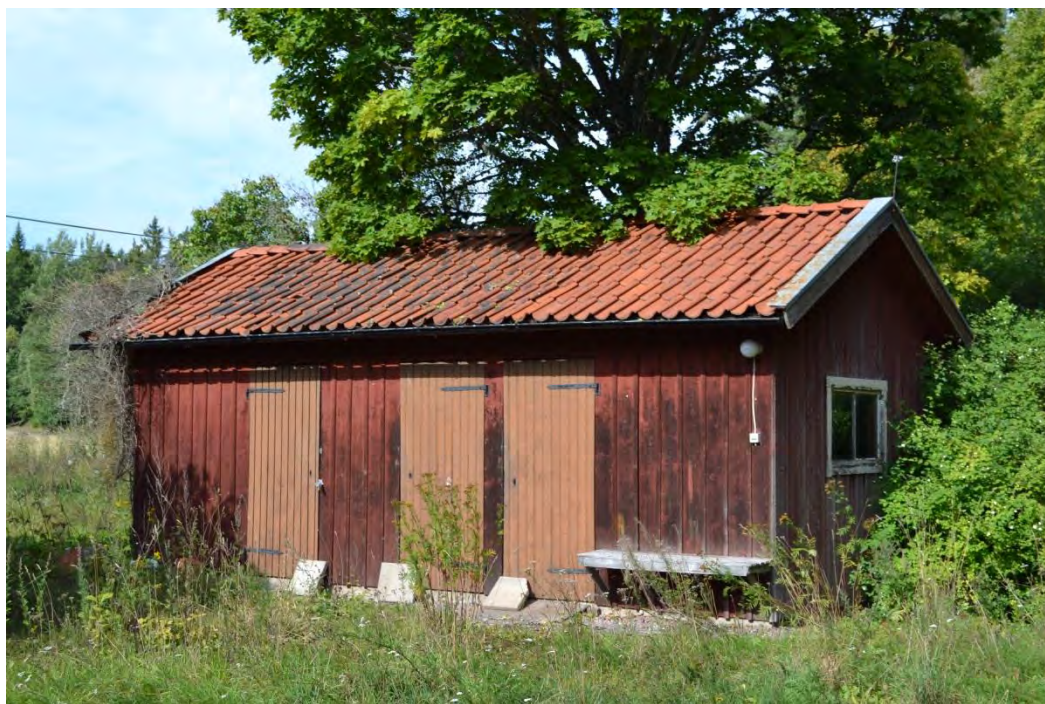
Bild 58. Hammarbys uthus, fasad mot söder.
