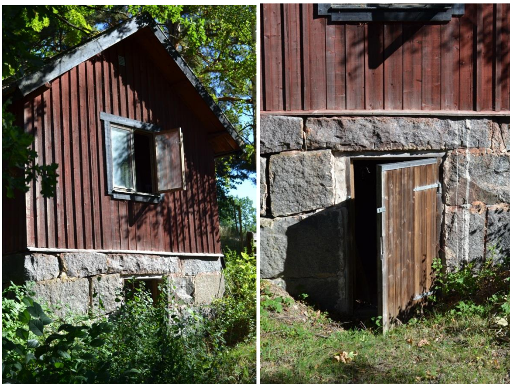
Bild 100. Naturskolans/Bläckhornets jordkällare/fårhus. Fasad mot söder.
