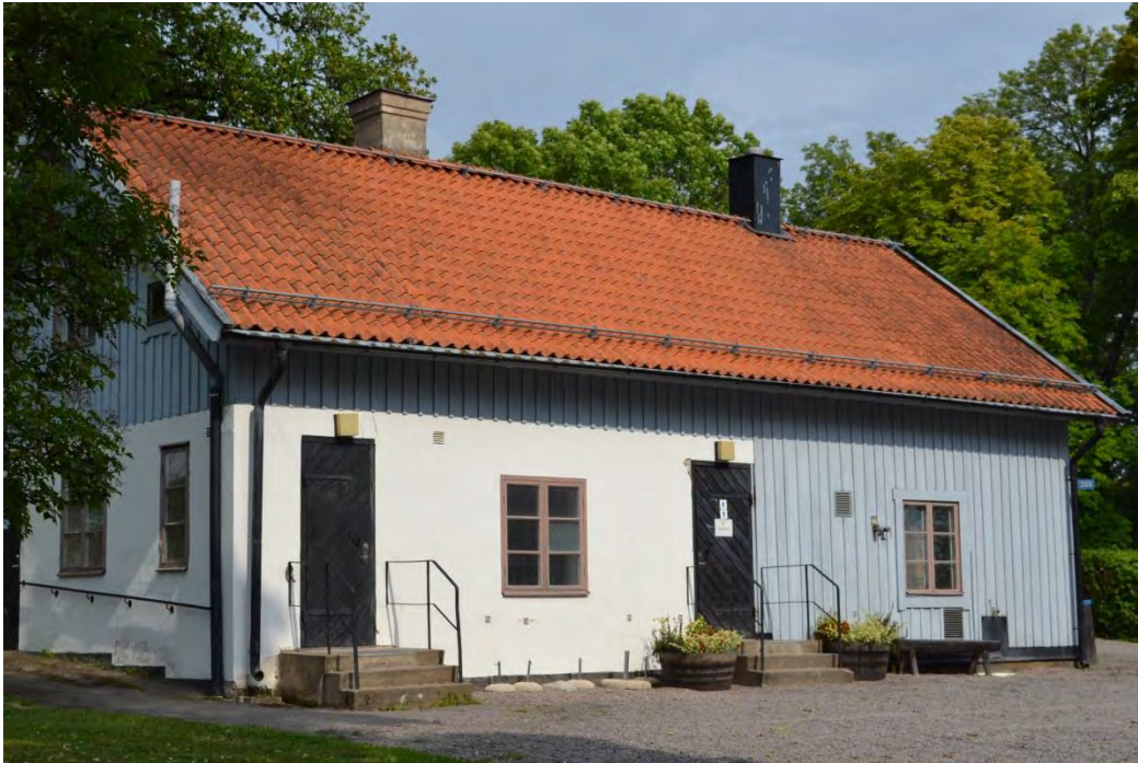
Bild 29. Garage/toaletbyggnad sedd från sydväst.
