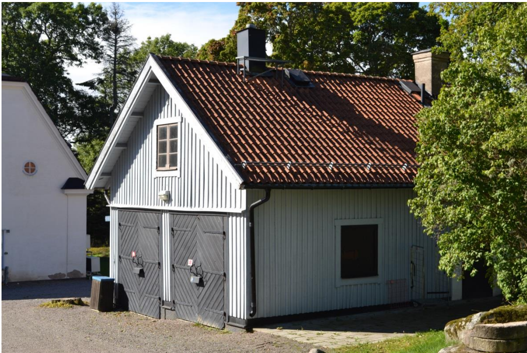
Bild 30. Garage/Toaletbyggnad sedd från nordöst.
