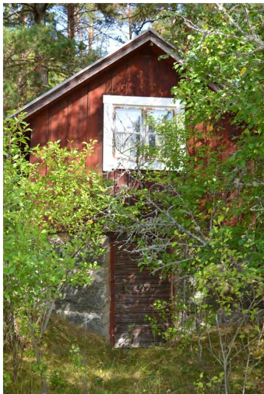
Bild 76. Fyristorps jordkällare med överbyggnad. Fasad sydväst.
