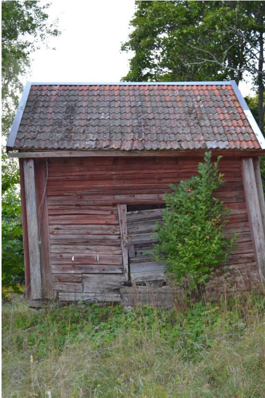
Bild 116. Ännesta magasinbyggnad/källarnattstuga. Öster fasad.
