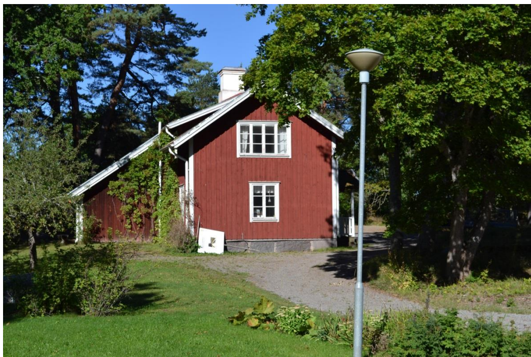
Bild 61. Bläckhornets bostadshus, fasad mot väster.
