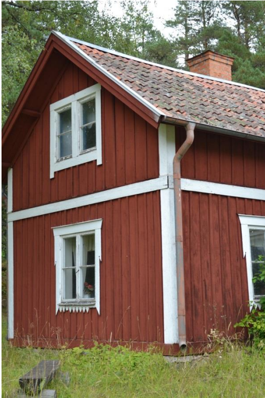
Bild 74. Fyristorp, nordvästlig fasad.
