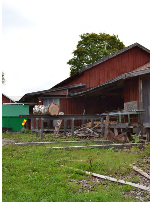
Bild 44. Traktorgarage/lider fasad mot norr med tillbyggnader och arbetsytor.
