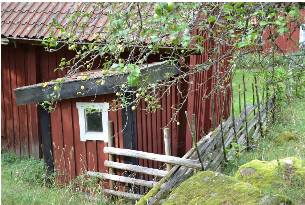
Bild 71. Österbergstorpets höns hus östra fasad. TC närmst i bild.
