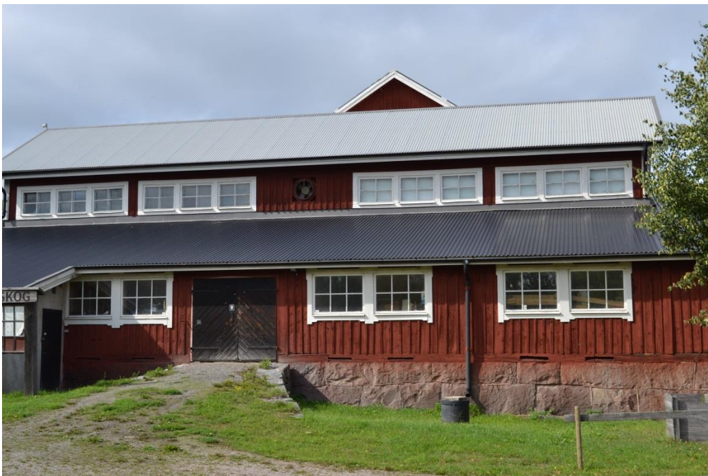
Bild 36. Snickeriets östra fasad.
