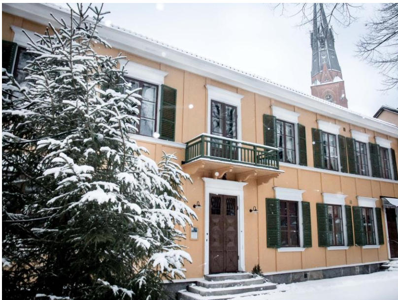
Renovering av fasad och tak har påbörjats på Walmstedska gården
