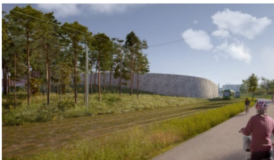
Figur 14 Exempel på mur där marknivån innanför och utanför depåområdet skiljer sig markant. (White, & Rundqvist) Vy från sydöst, mot kollektivtrafikboulevarden, där höjdskillnaden är som störst och ett begränsat utrymme mellan spår och depå gör att hela höjdskillnaden behöver tas upp av muren.
