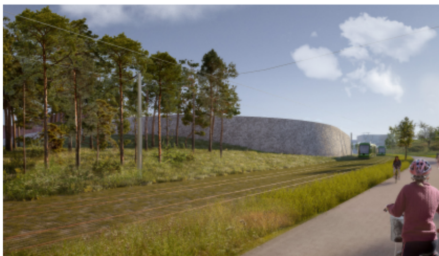
Figur 8 Illustration av exempel på mur - när marknivån innanför och utanför depåområdet skiljer sig markant. (White, & Rundqvist) Vy från sydöst, mot kollektivtrafikboulevarden, där höjdskillnaden är som störst och ett begränsat utrymme mellan spår och depå gör att hela höjdskillnaden behöver tas upp av muren.
