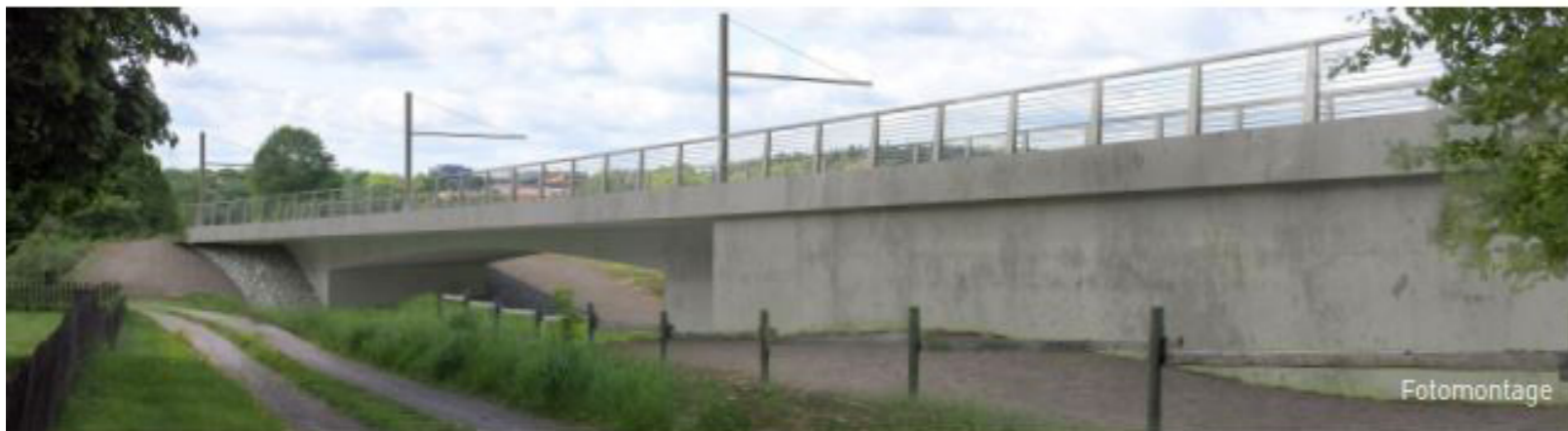
Spårvägsbron över Hemslöjdsvägen.
