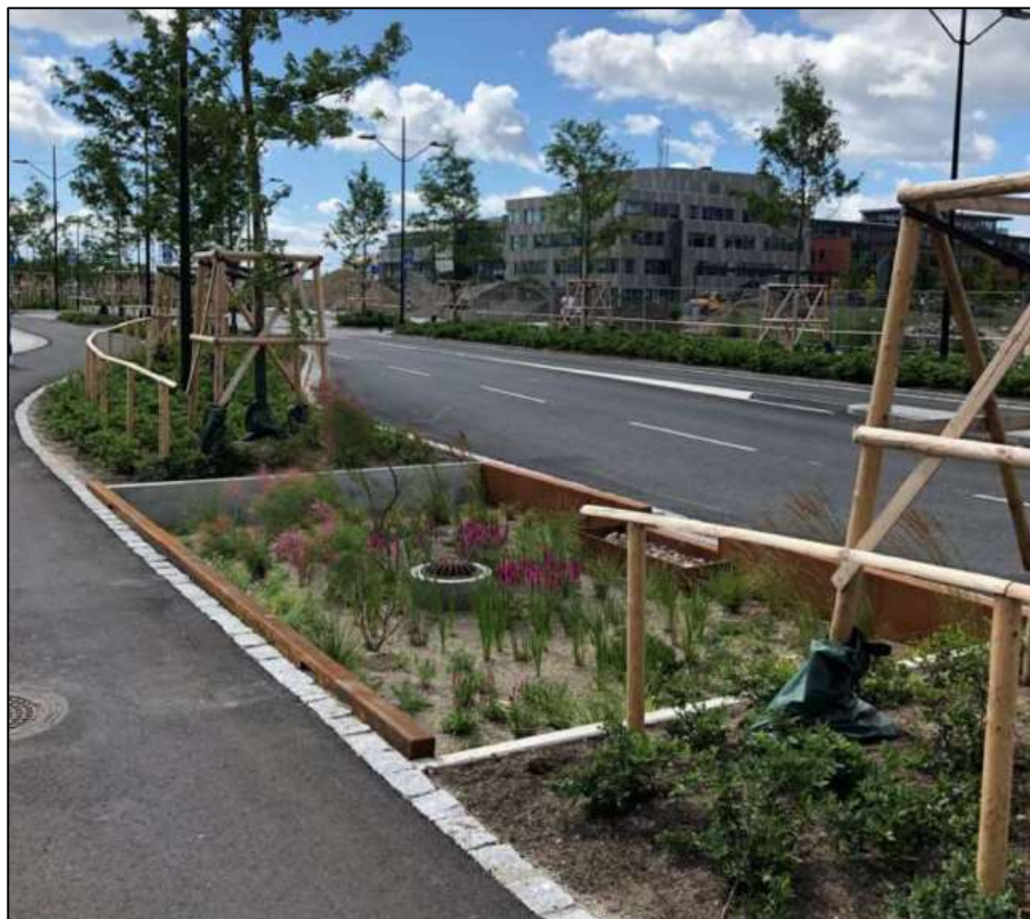
Figur 5:6. Nedsänkt regnbädd i Malmö med erosionsskydd vid inloppet och bräddutlopp i form av en kupolbrunn (Foto: Norconsult)
