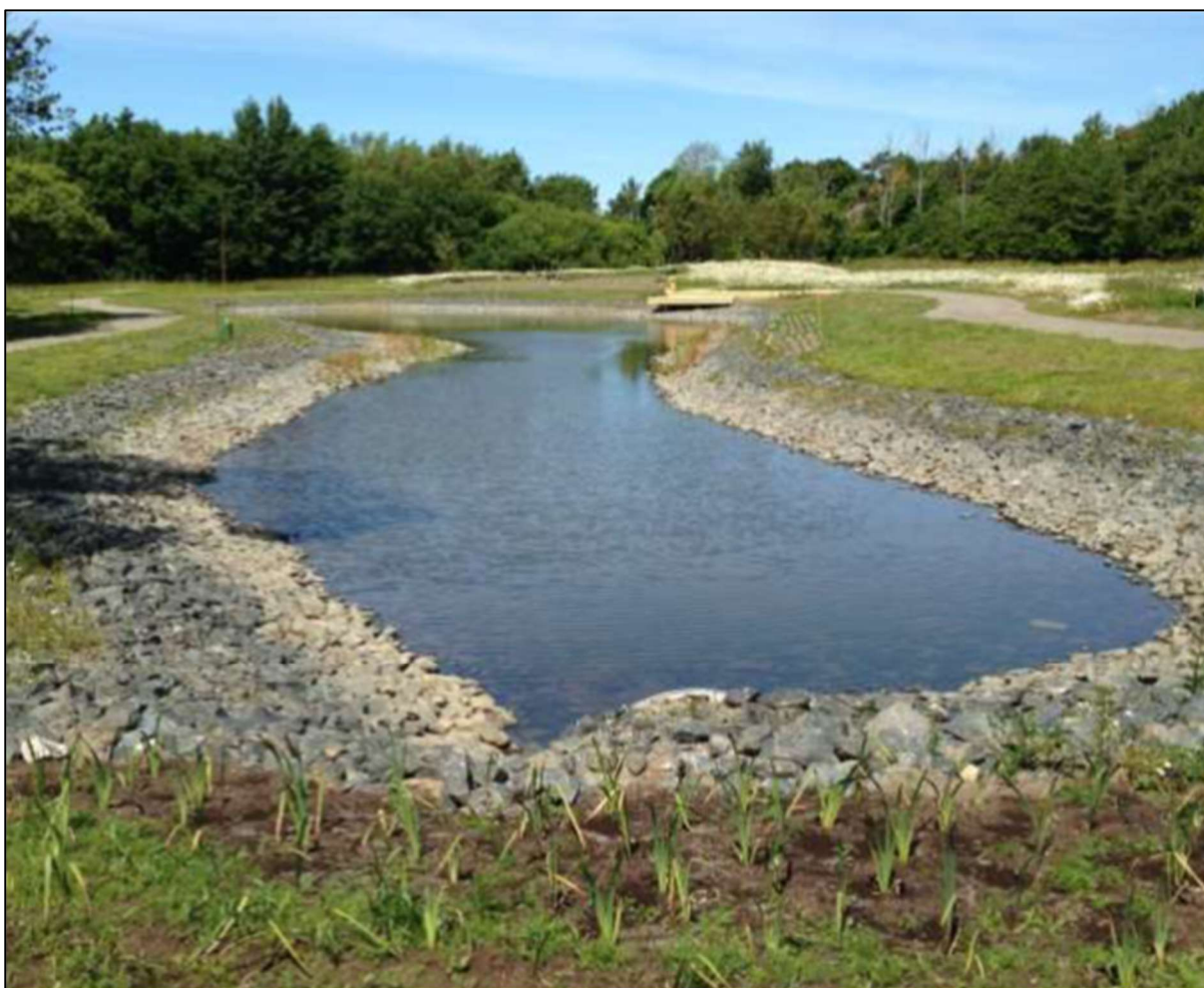
Figur 5:8. Exempel på dagvattendamm i Trönninge i Varberg. Foto: Norconsult
