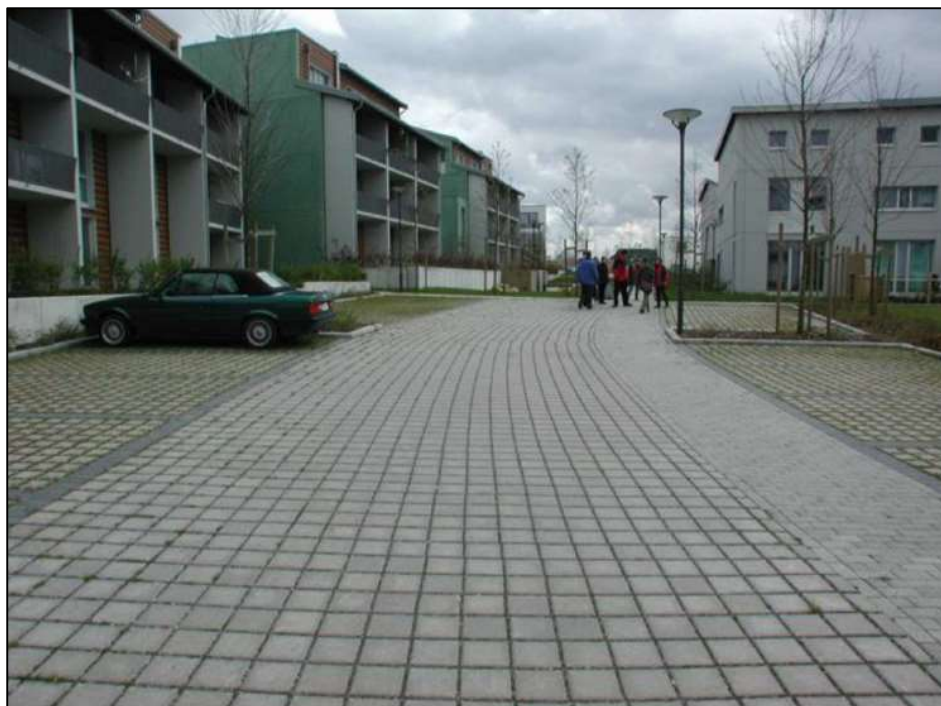
Figur 5:7. Parkering och gata med genomsläpplig beläggning (Foto: Norconsult)
