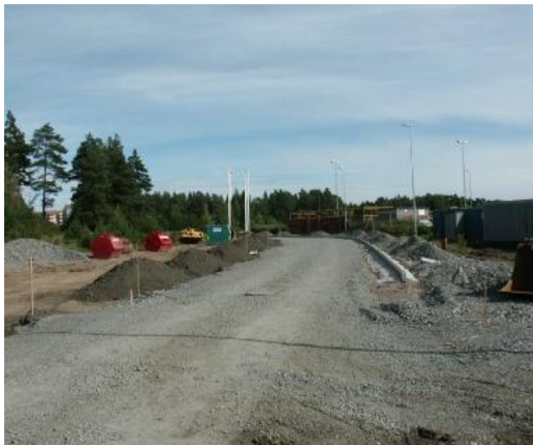
Naturstensvägen från väster (utbyggnad pågår).
