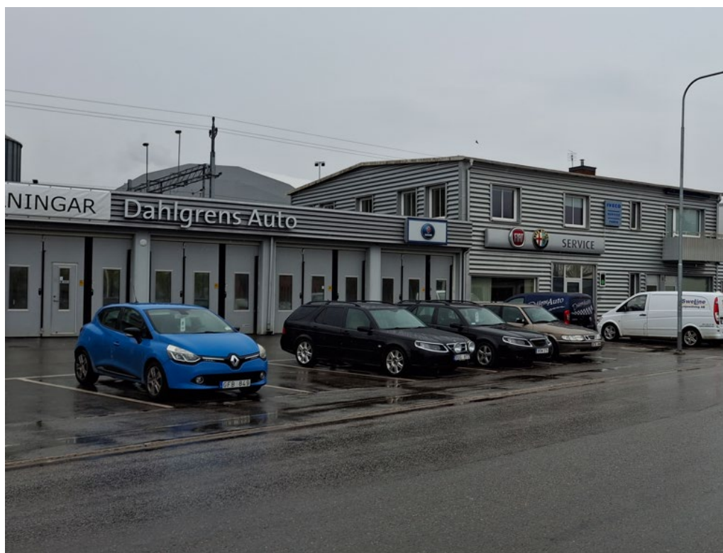
Figur 30. Byggnad på Kungsängen 36:1 som avses att rivas.
