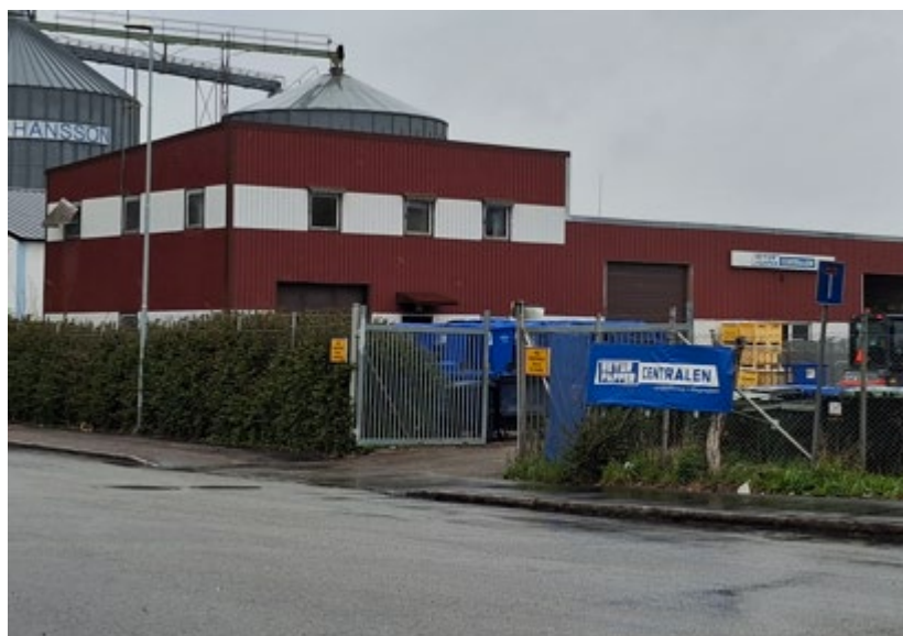
Figur 31. Byggnad på Boländerna 16:8 som avses att rivas.
