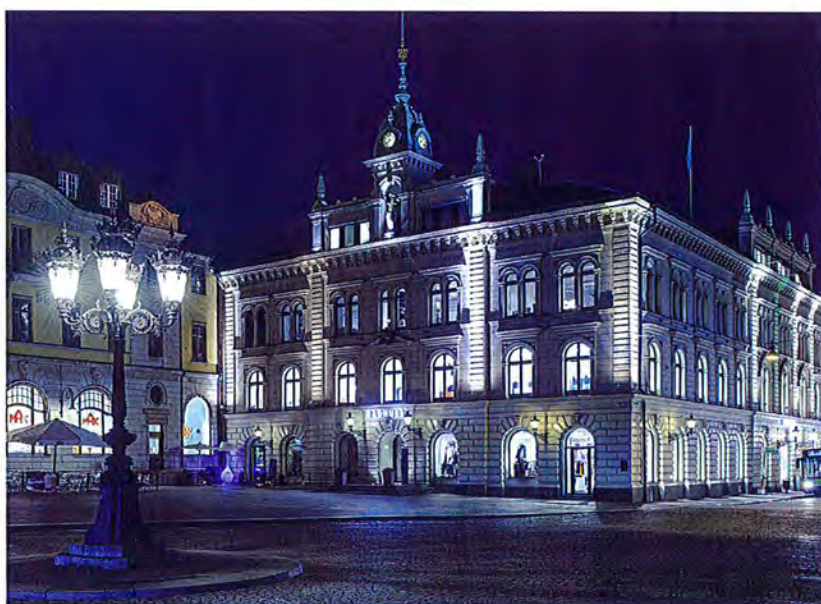
Fasadbelysning på Rådhuset vid Stora torget.
