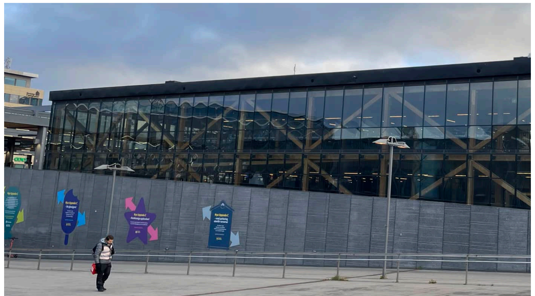
Figur 14. Exempel på befintlig byggnad med trästomme och glasfasad inom stationsområdet. Byggnaden planeras dock att demonteras och flyttas till ny plats utanför projektet i samband med nyggnation av det nya stationshuset.
