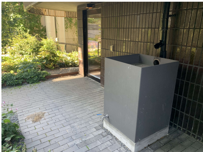
Figur 21. Exempel på stuprör som ansluter till regnskördartunna. Foto: Bjerking AB.
