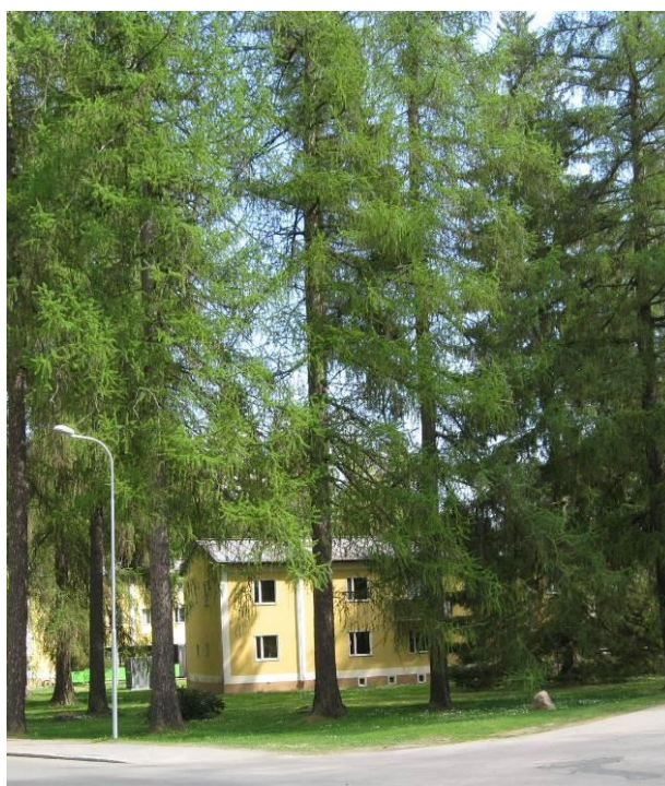
Figur 4.5.3. Riven byggnad (hus 56)
