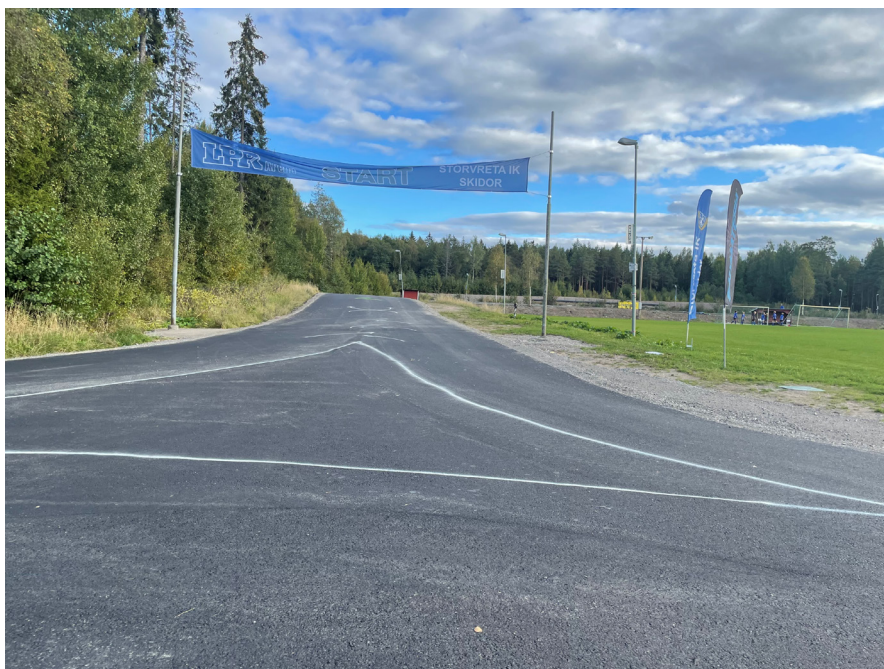
Bilden visar del av Storvreta IP multiarena.
