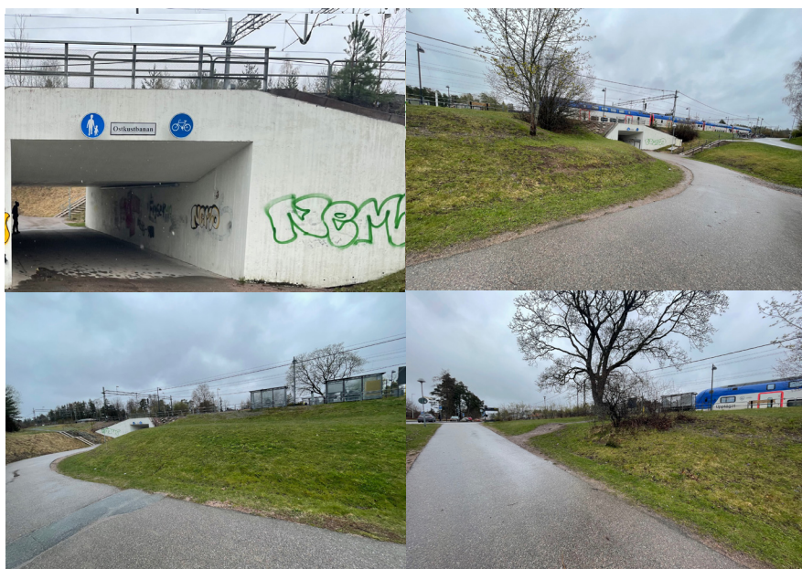
Bilderna visar tunnel vid stationsområdet.
