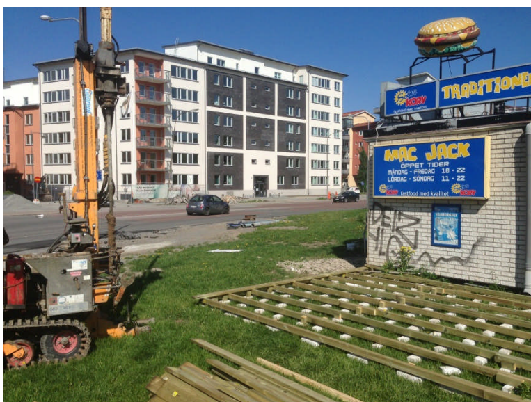
Figur 4. Grill-restaurang och provpunkt BH7/GV2 i sydvästra delen av fastighet.
