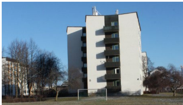
Bild 47 Bilden visar takvinkeln på en gavelfasad för ett av de befintliga skivhusen.
