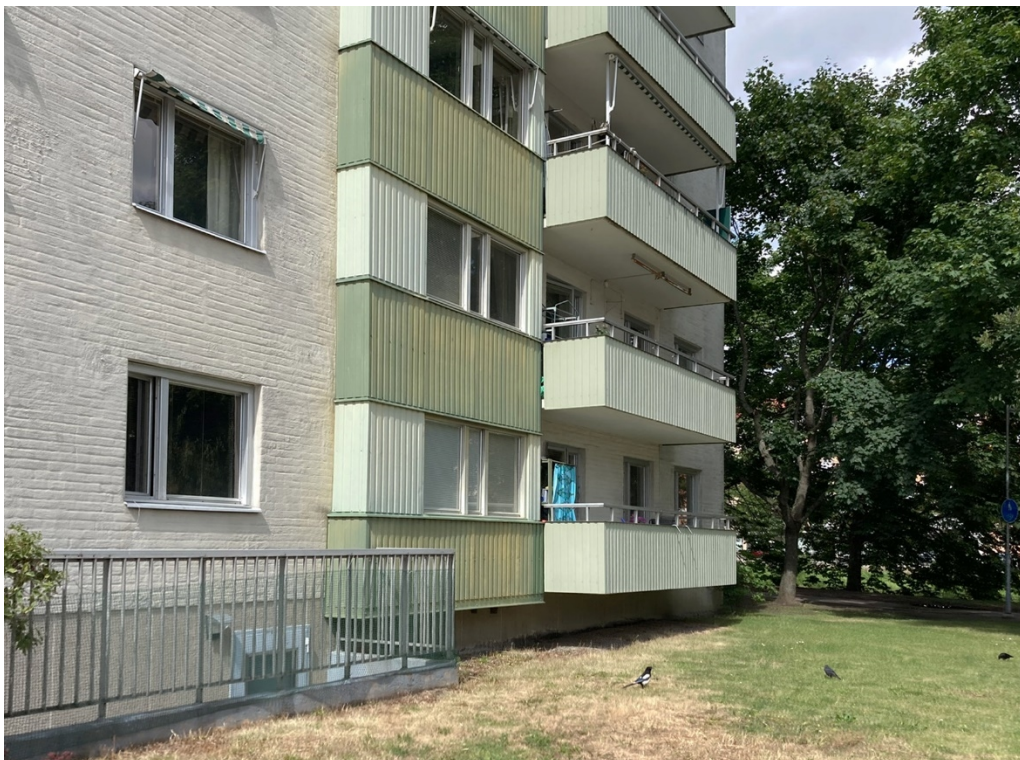
Bild 7. Foto som visar fasaden med plåtinklädda burspråk och balkonger som vetter mot Torsgatan.
