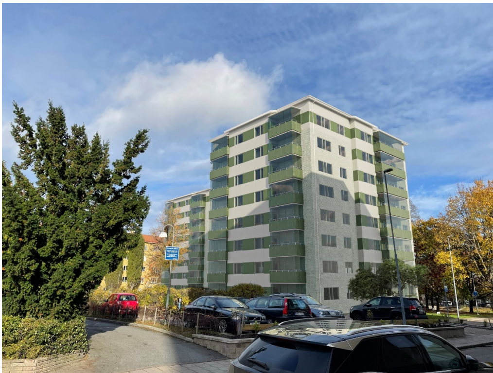
Bild 8. Illustration från fastighetsägaren som visar punkthusen efter en fasadrenovering där plåtpartierna bytts ut och ytterligare en bostadsvåning har byggts på. Vyn är tagen från Torsgatan. Illustrationer: PE Teknik & Arkitektur
