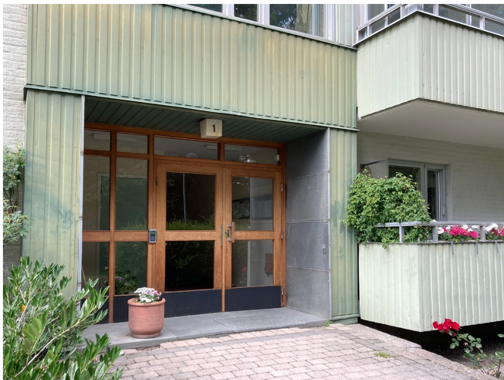
Bild 8. Foto som visar entrén till den norra byggnaden inom fastigheten.
