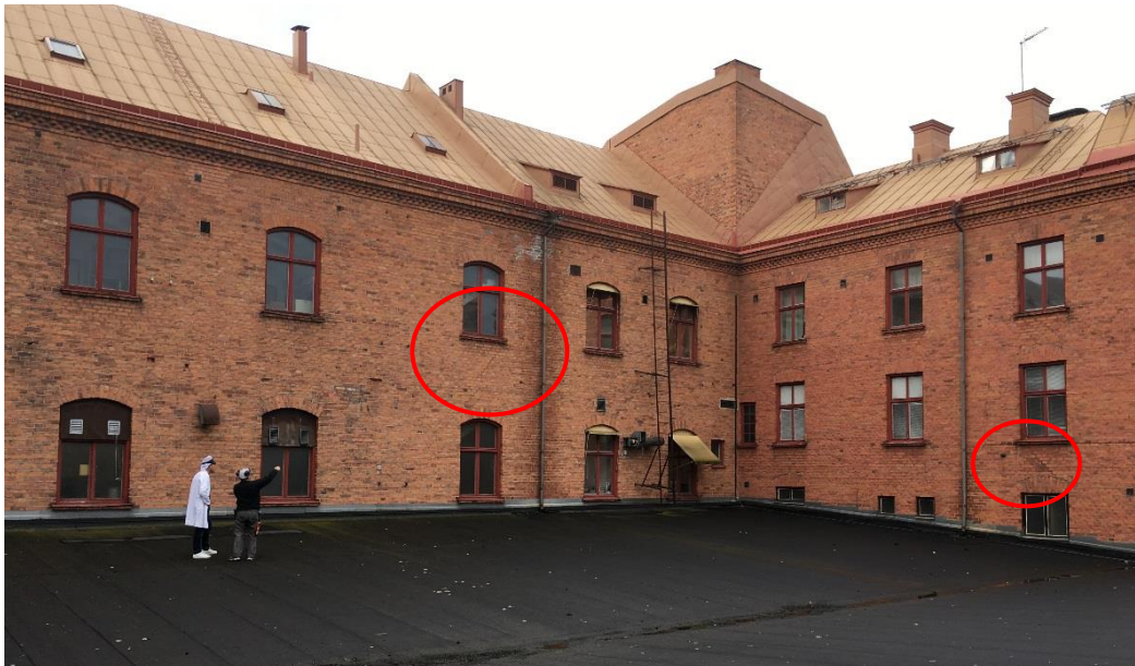
Figur 10 Sprickbildning i södra fasaden av Jästfabriken, Platsbesök 2016-10-28
