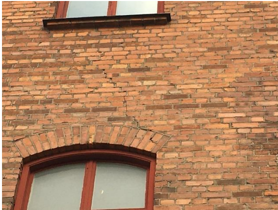
Figur 10 Sprickbildning i södra fasaden av Jästfabriken, Platsbesök 2016-10-28
