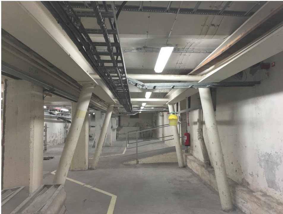
Figur 12 Sektion B-B ( figur 8 ), förstärkning av grundläggning, Jästfabriken
