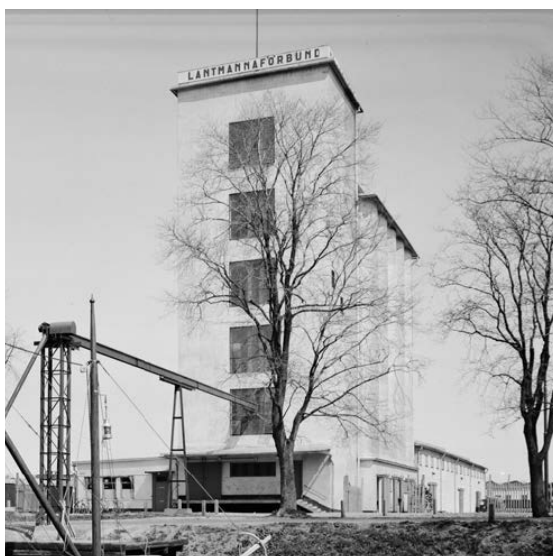
Betongsilon från 1939, även kallad ”Silo 1” med sitt ursprungliga utseende. Foto: Upplandsmuseet
