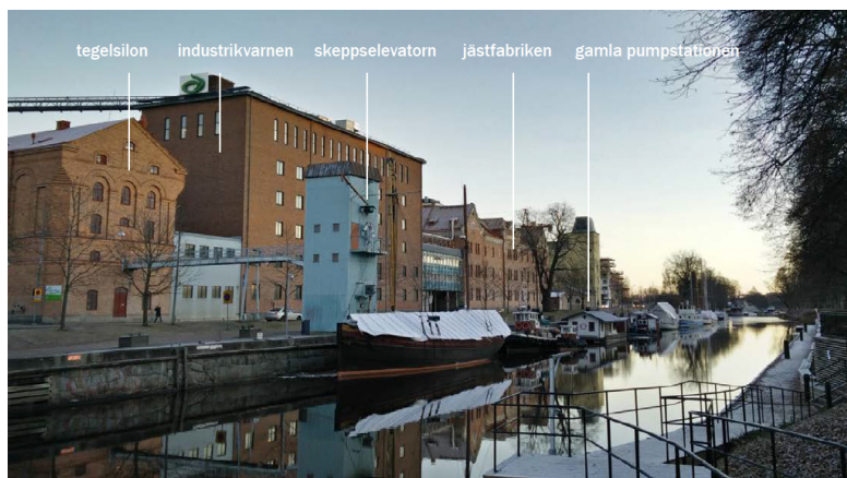
Byggnadsfront mot Fyrisån med bevarandevärda byggnader utmarkerade. (Planeringsinriktning 2018, Uppsala kommun).
