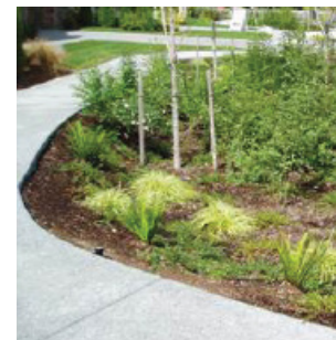
Exempel på en nedsänkt vegetationsbädd. Här kan dagvatten tas omhand och fördröjas (Gestaltningssprogram Ångkvarnen, 2019)
