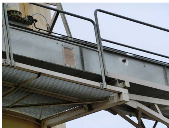
Transportör från spannmålmottagningen till kvarnanläggningen under pågående spannmålstransport.
