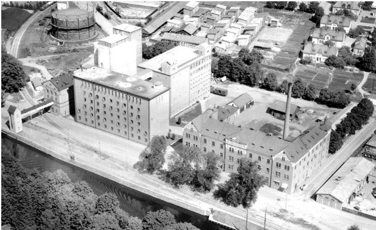
Flygfoto från 1947 som visar kvarteret Ångkvarn efter att huvuddelen av bygnadsprogrammet blivit genomfört. Den gamla kvarnbyggnaden har gett plats för mjölsilo och macaronifabrik samt en modern spannmålsilo med betongceller, maskintorn och lanternin. Under 1948 utökades den nybyggda silon så att den kom att sträcka sig till den gamla tegelsilon närmast hamnen. Observera skorstenen till jästfabrikens ångpanna. Foto AB Flygtrafik 1947/UM.
