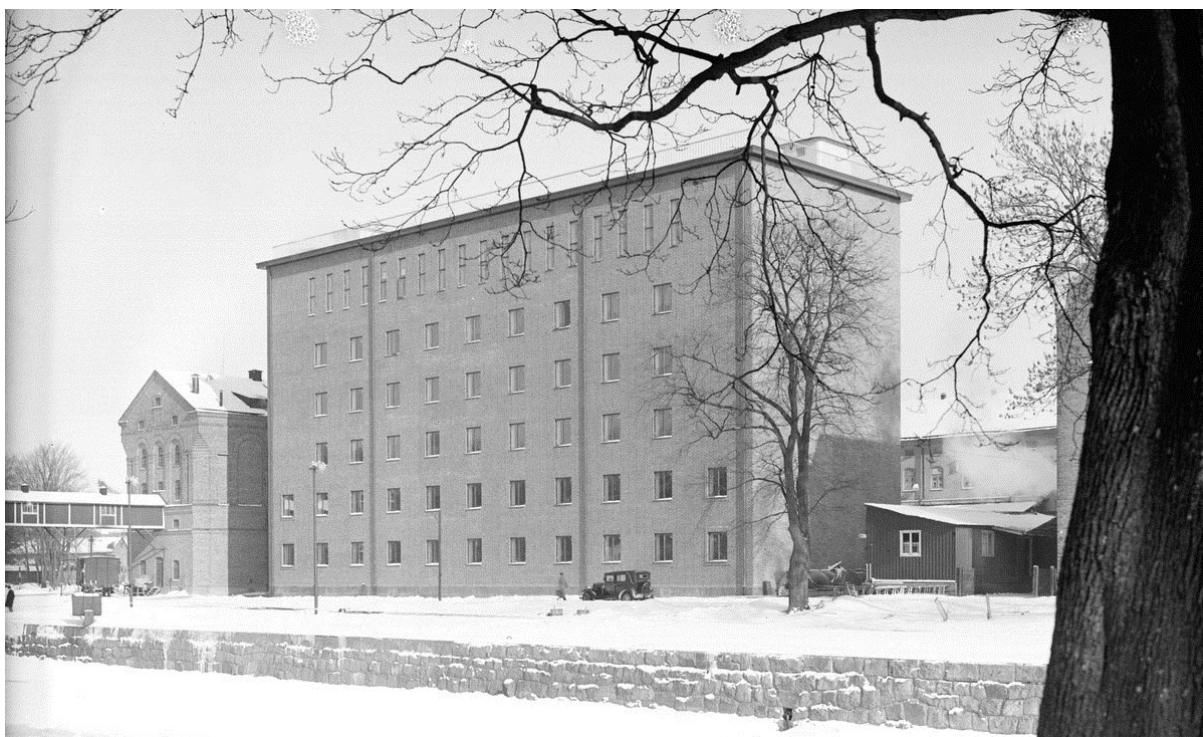
Den nya kvarnbyggnaden strax efter uppförandet. Foto Gunnar Sundgren 1944/UM
