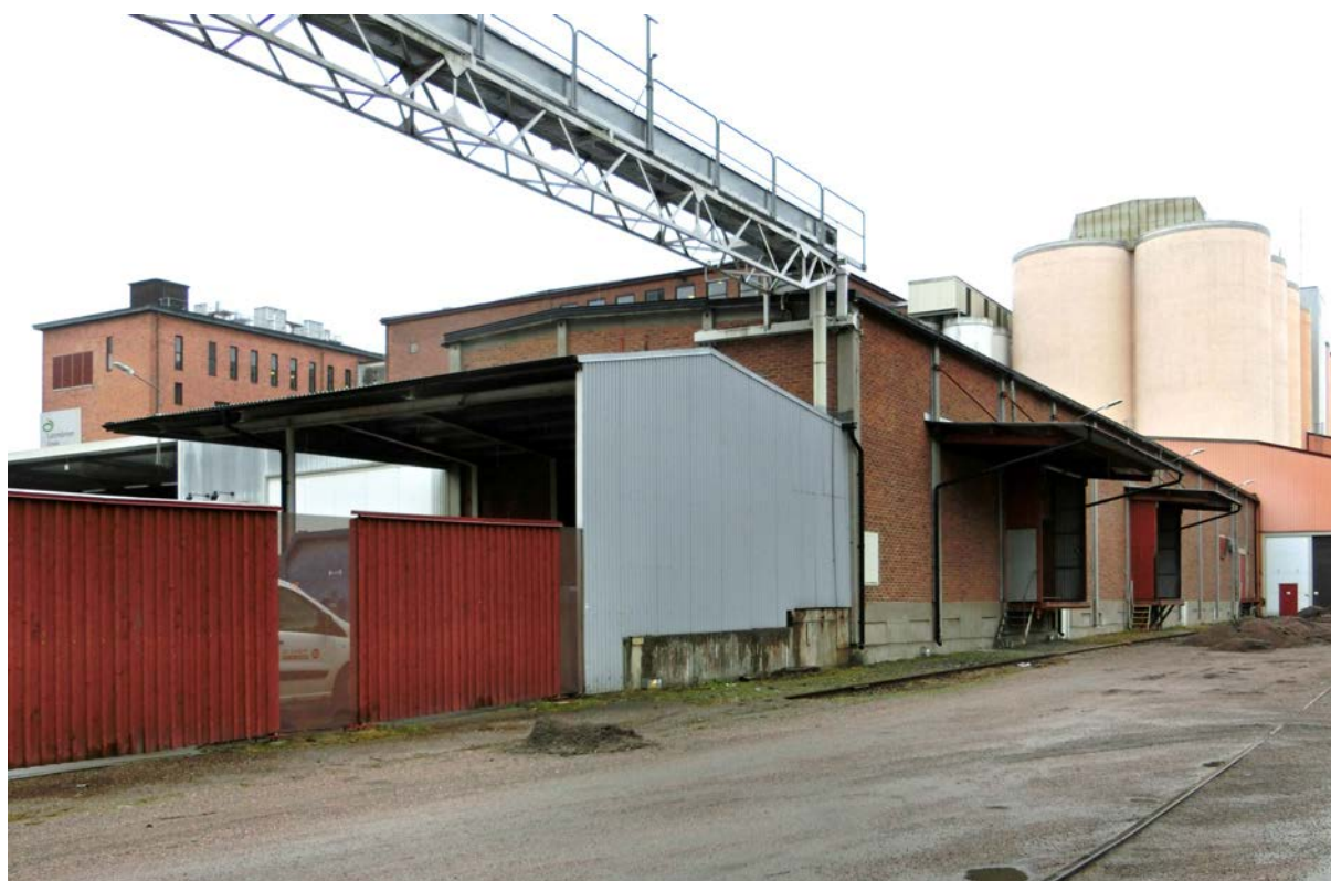
Magasinet med transportör av spannmål från silo i spannmålmottagningen i kvarteret Fabriken.
