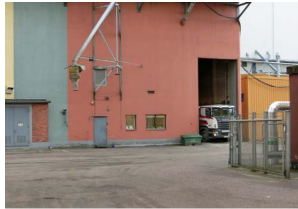
Lossning av lasten i tippgroppen i maskinbyggnaden till silon från 1977 i f.d. kvarteret Upplaget.
