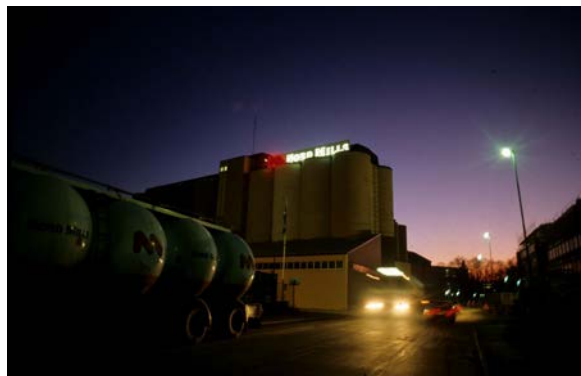
Kvarnen i mörker med in- och utlastningsbyggnad och pågående transporter. Foto troligen 1990-talet, Tommy Arvidsson/UM
