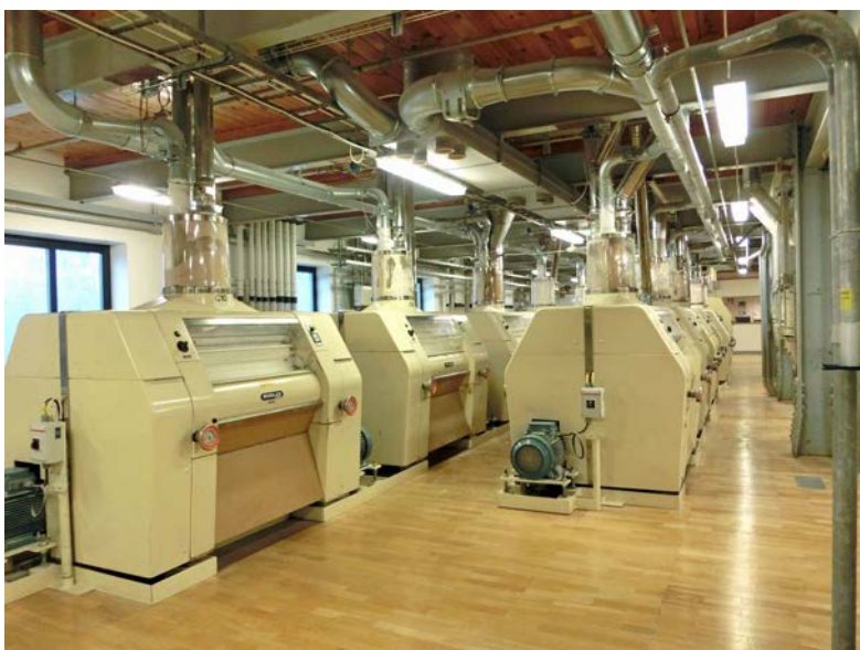
Hall med valsar på våning 1 i kvarndelen. Bjälklagen består av fristående järnbalkar med parkettgolv för att minimera vibrationerna från maskinerna.
