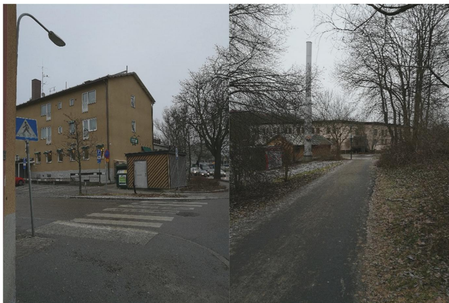
Avloppspumpstationer vid bostadshus respektive hotell i närheten av Brommaplan.
