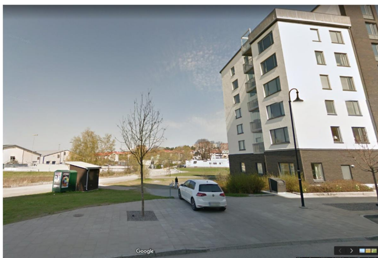
Avloppspumpstation utan luktreningsutrustning, Frösunda i Solna.
