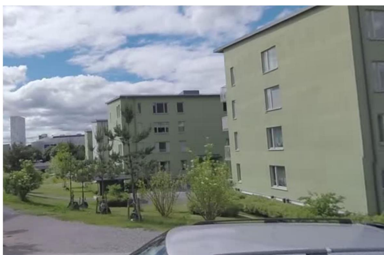
Avloppspumpstationer med luktreningsutrustning i Frösunda i Solna.
