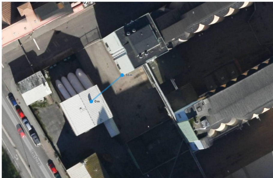
Bild 2. Avstånd mellan ventilationsutsläpp och silobyggnad. Bilden visar de tidigare otäta täckplåtarna över pumparna.
