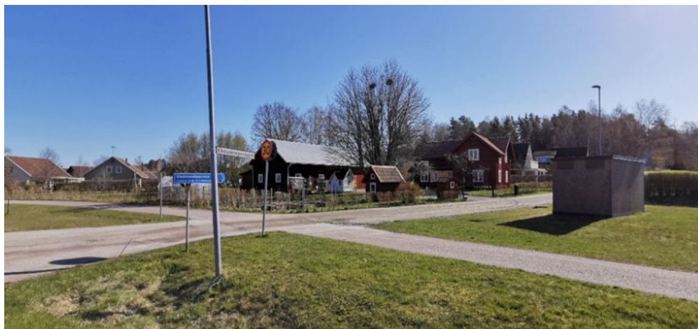
Figur 11. Östantorpsvägens infart från Malmvågsvägen som korsas av gång- och cykelvägen. Mitt i bilden syns bebyggelsen inom Lena 1:5, och till höger i bilden syns transformatorstationen inom fastigheten Vattholma 5:20.
