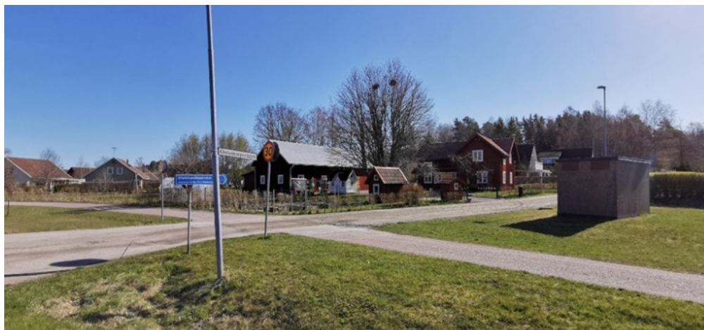
Figur 11. Östantorpsvägens infart från Malmvågsvägen som korsas av gång- och cykelvägen. Mitt i bilden syns bebyggelsen inom Lena 1:5, och till höger i bilden syns transformatorstationen inom fastigheten Vattholma 5:20.
