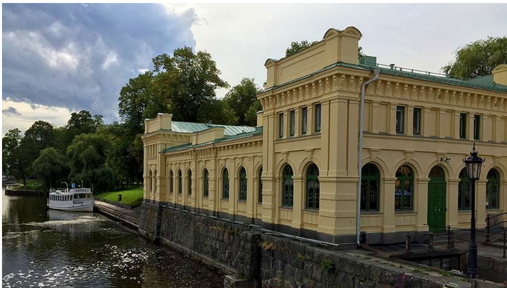
Figur 12 - Vattenverket, även kallat pumphuset, är beläget intill Fyrisån.
