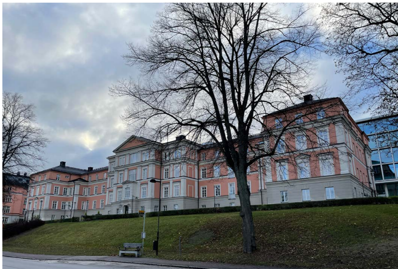
Den ursprungliga sjukhusbyggnaden som den ser ut idag. Grönytan som omger byggnaden minner om den park som anlades i anslutning till sjukhuset.
