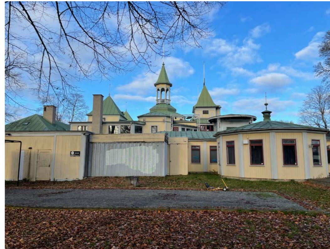
Ovan till vänster: Köksbyggnaden utmärker sig genom sin putsade fasad. Vindsvåningen inreddes på 1950-talet för personalutrymmen.
