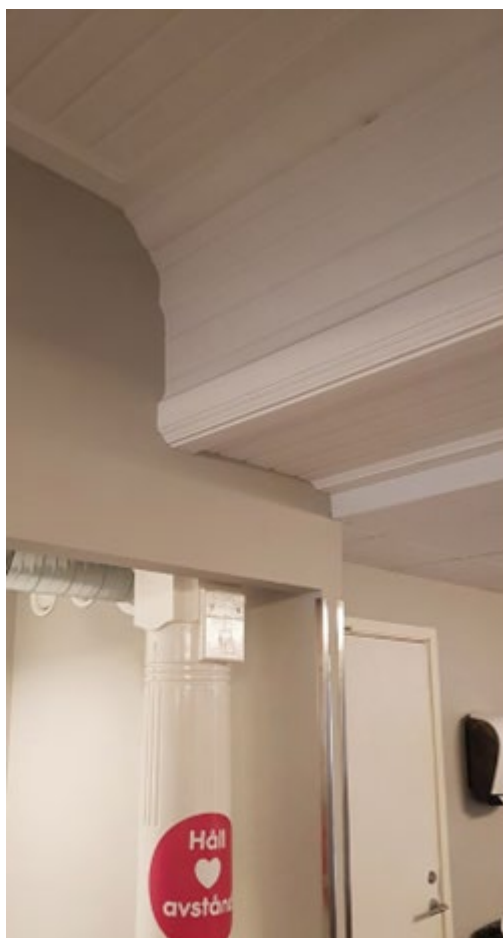
Bild 9 - Detalj av balkar och tak klädda i trä och gjutjärnspelare, Sweco
