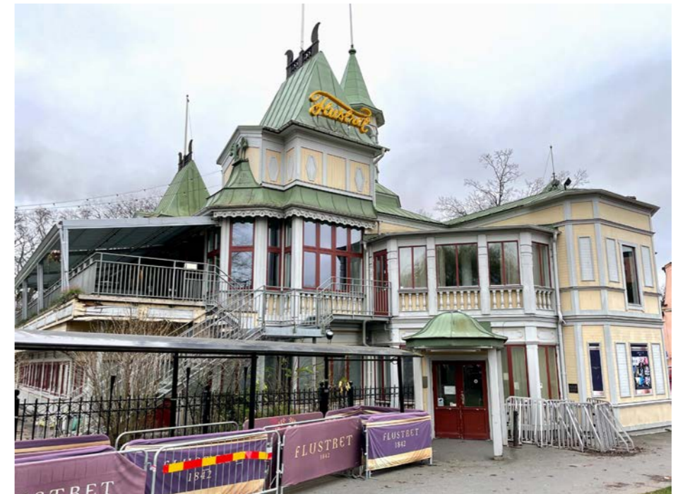
Huvudentrén till Flustret är sedan länge belägen på norra sidan. Taket ovan entrén tillkom eventuellt på 1990-talet.
