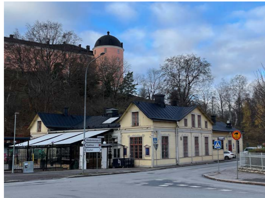
Nattklubb Birger Jarl, tidigare Barowiak, var ursprungligen en del i Uppsala kallvattenkuranstalt och blev sedan föreningshus. Byggnaden representerar det sena 1800-talets och tidiga 1900-talets träarkitektur kännetecknad av bland annat hyvlade paneler och snickarglädje.
