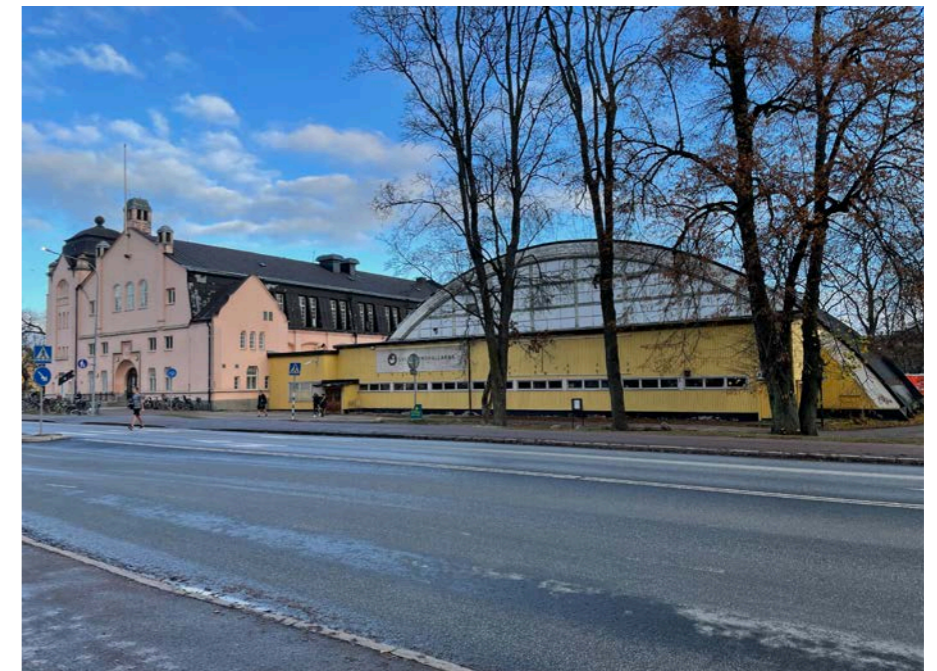
Svettis och den senare tillbyggda Bollhallen från Sjukhusvägen.
