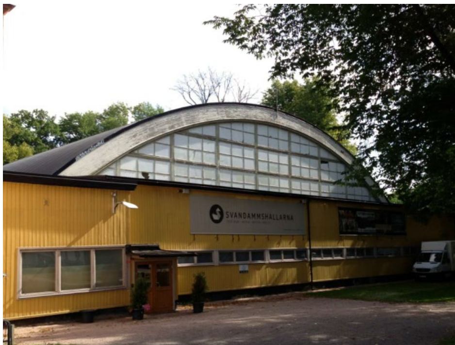
Bild 10 - Bollhusets framsida mot väster, Stockholms byggnadsantikvarier AB, 2013
