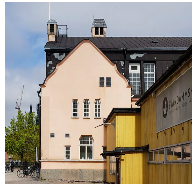
Gavelfasad mot söder och bollhuset
