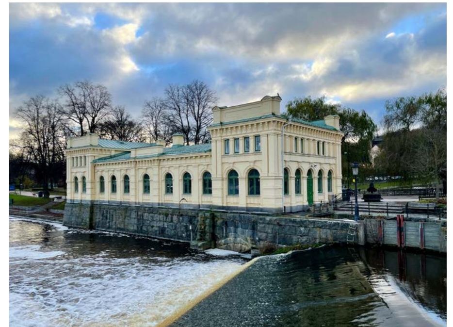
Den äldsta delen av Pumphuset vid Islandsfallet härrör från 1875 då Uppsala första vattenverk invigdes. 1900–01 skedde en större utbyggnad. Till höger kan vad som troligen var intaget till turbinen anas. Vid vattenlinjen nedanför fallet anas en välvd utloppsöppning.
