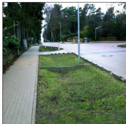
Figur 10. En principskiss för ett svackdike (t.v.) samt exempel på svackdike innehållande dämmande sektioner vilket förstärker den fördröjande kapaciteten. Bildkälla: WRS, Stockholm vatten och avfall.
