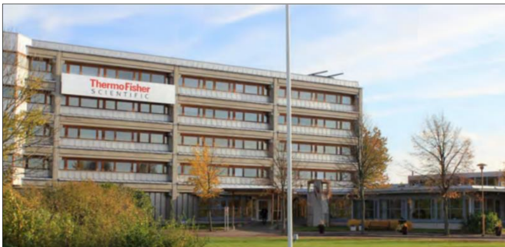
Bild 31. Huvudkontoret (hus 35) och den lägre matsalsbyggnaden (hus 31). Foto: Kulturmiljöutredning, WSP.
