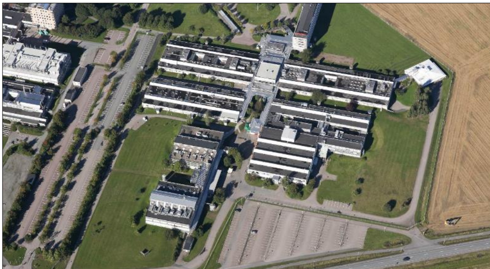
Bild 12. Flygbild orienterad mot norr. I bildens överkant syns Thermo Fishers (Phadias) huvudkontor (hus 35). I framkant mot Almungevägen syns de lägre laboratoriebyggnaderna.
