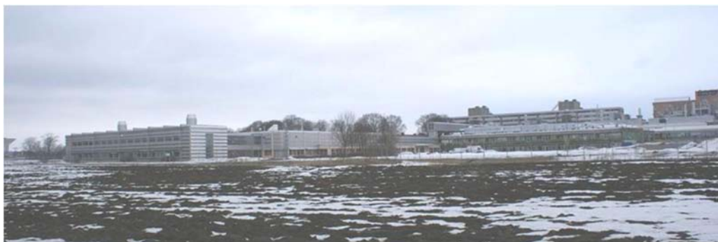
Figur 25 Klöverns bebyggelse från Almungevägen. Från vänster hus 16b och 16a, hus 1 samt hus 13 och 14 dominerar i bakgrunden och framför dem hus 5 och 4b samt ventilationsanläggningen på 3b.
