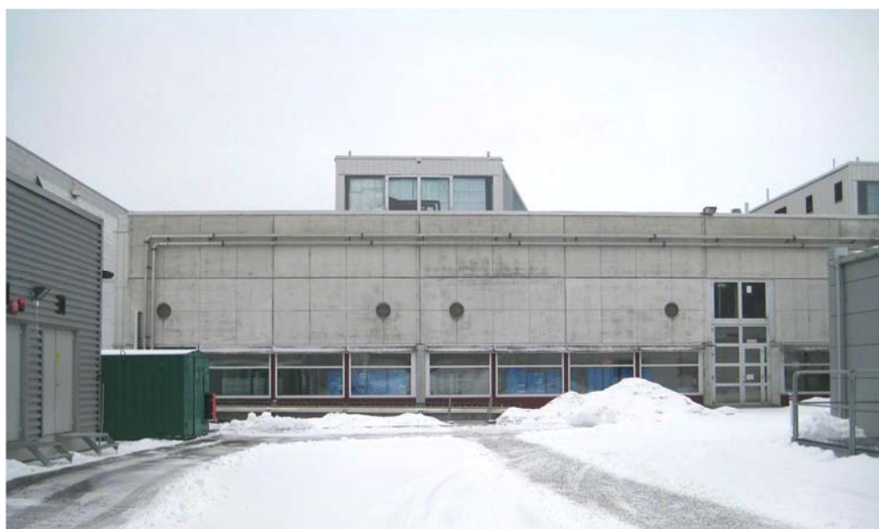
Figur 30 AMO, hus 21 norra fasaden.
