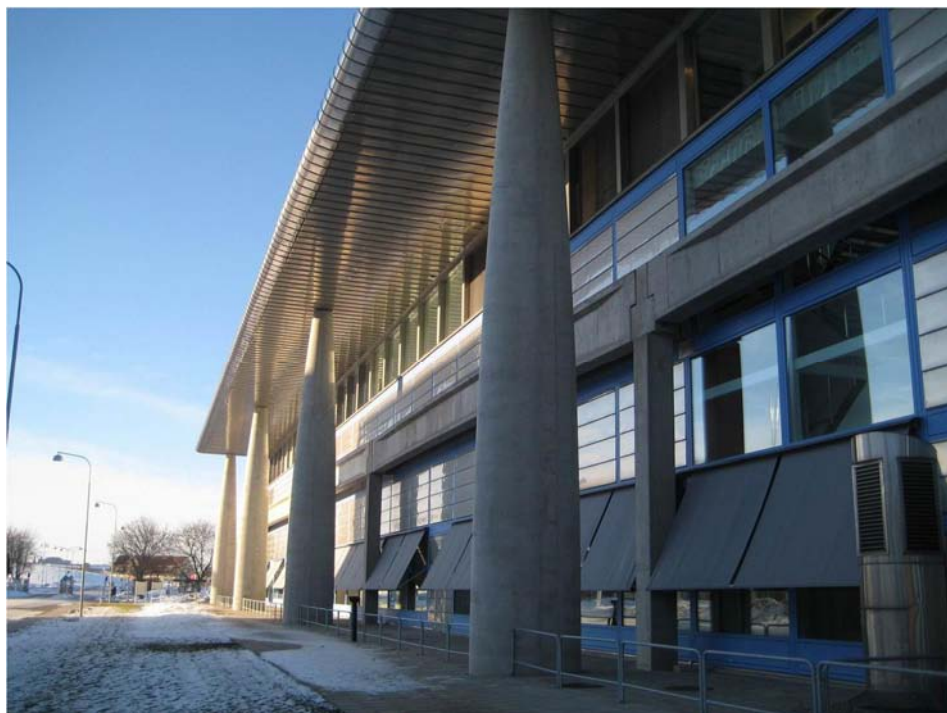
Figur 31 Fresenius-Kabi, fasaden av hus 6a mot Virdings allé.
