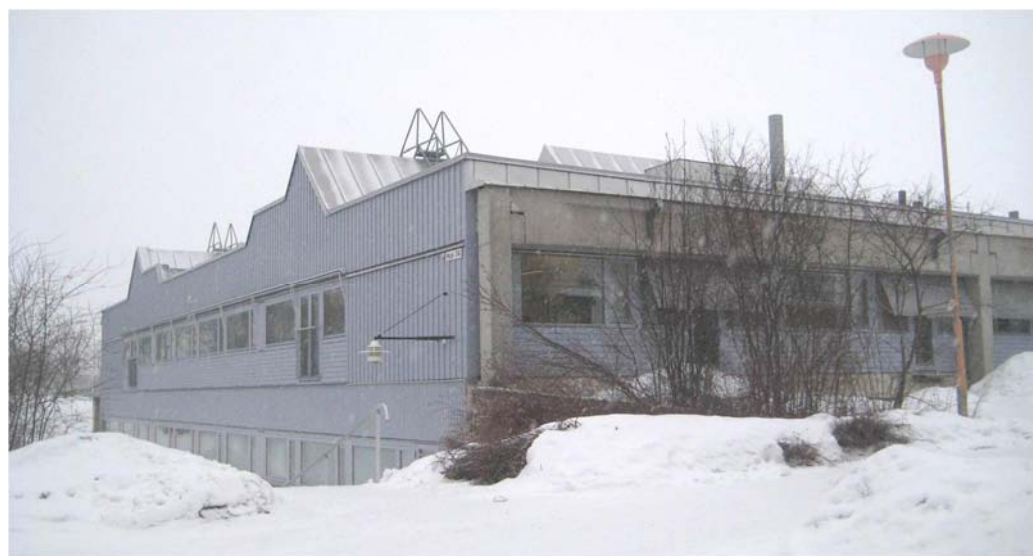
Figur 28 Phadia, gaveln på hus 34 med typisk siluett med långsträckta lanterniner som ger norrljus och synlig utvändig stomme. Trappräckena över lanterninerna tillhör ursprunglig utrustning.
