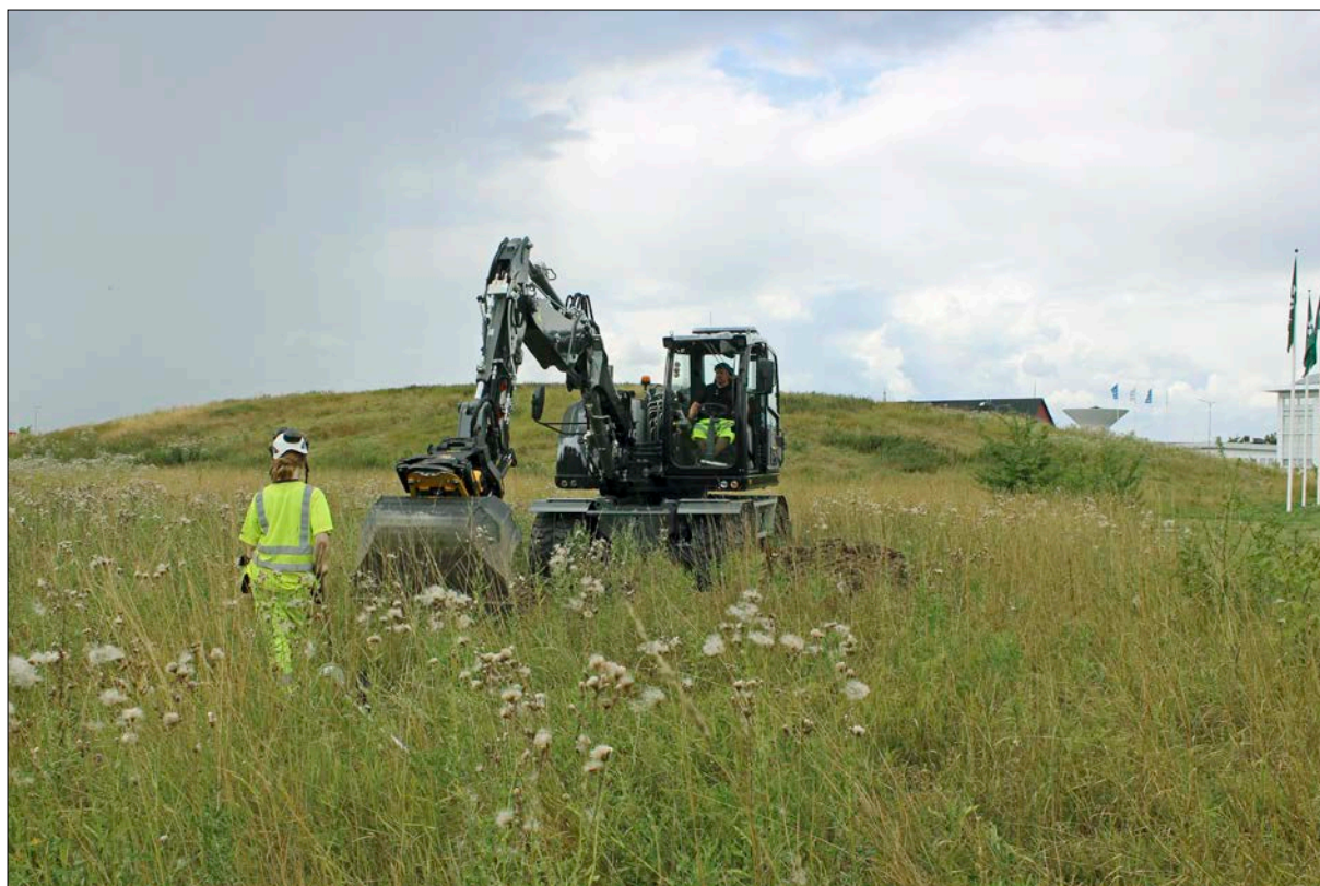
Figur 3. Sökschaktning i utredningsområdets nordvästra del. I bakgrunden syns en av flera högar med påförda massor som fanns i området, den här omkring 100 meter i diameter och fem meter hög. Foto från sydöst.
