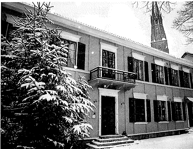
Renovering av fasad och tak har påbörjats på Walmstedska gården
