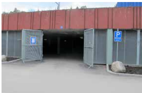
Parkeringsdäck inom kvarteret Linklubban, mellan Hugo Alfvéns väg och Bandstolsvägen.
